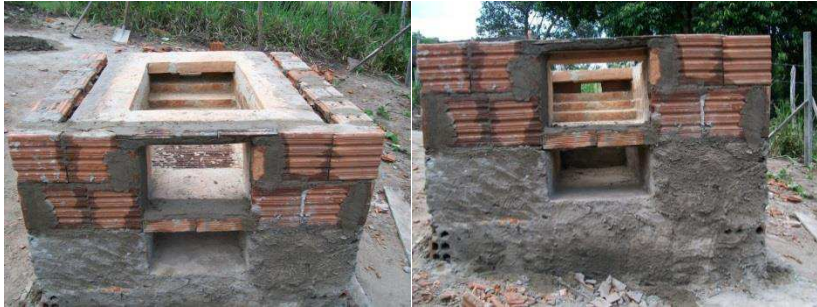
Figura 3: Construção do fogão ecológico.
