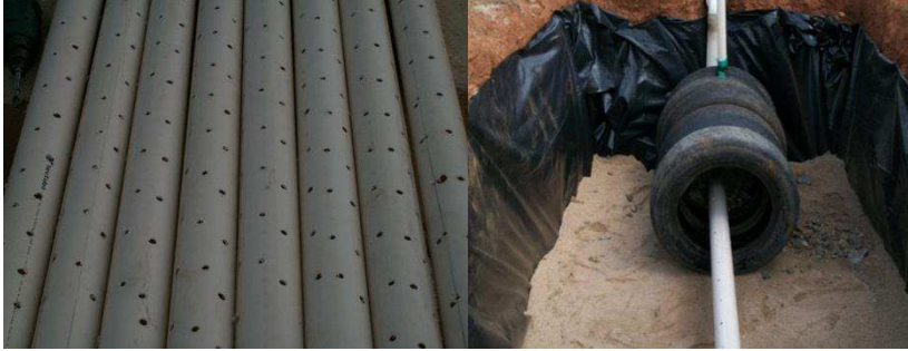
Figura 2. Tubo de PVC perfurados e a instalação do tubo e dos pneus.
