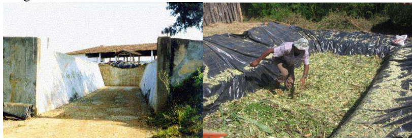
Figura 6. Silo Trincheira em Alvenaria e Silo Trincheira sendo carregado.
