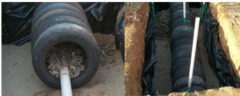
Figura 4. Início do preenchimento do tanque.
