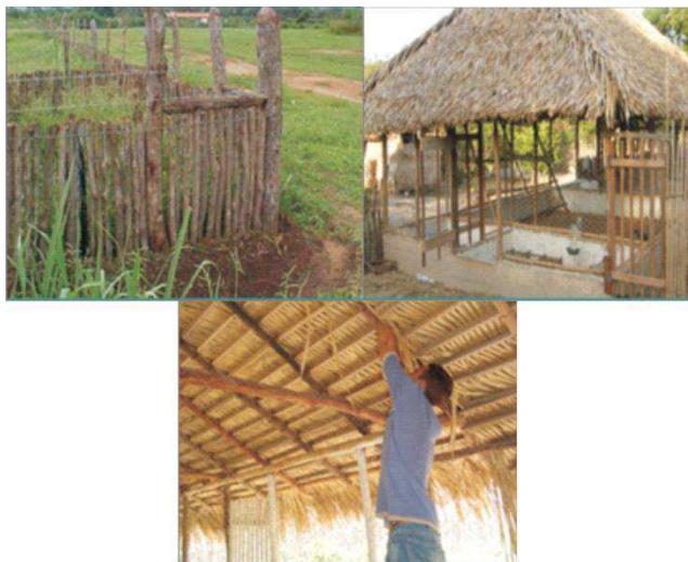
Figura 1. Instalações com materiais encontrados na propriedade. Fonte: EMBRAPA (2012).
