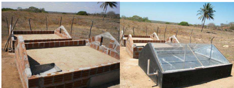
Figura 5: Construção dos destiladores (12 metros 2 ) no Sítio Lagoa da Serra, Soledade/PB.
