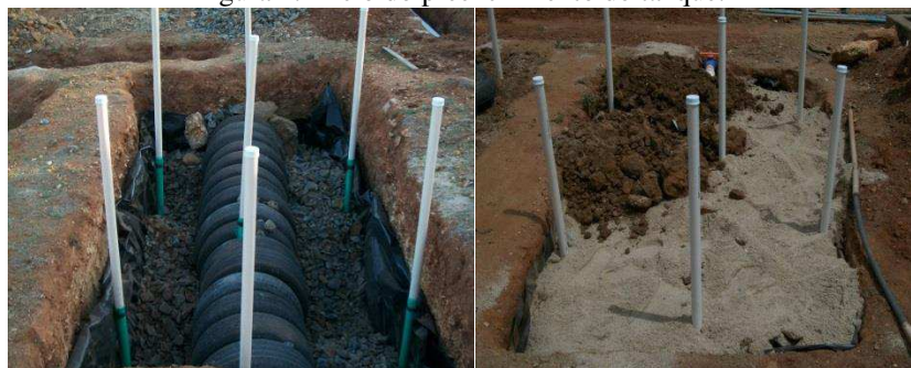
Figura 5. Preenchimento do tanque evaporímetro.
