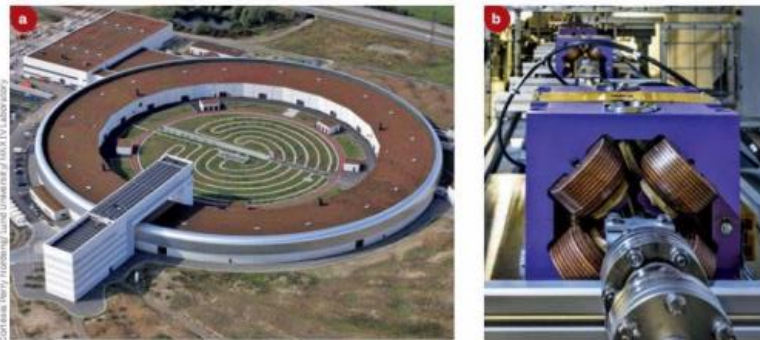
Figura 49: (a) Vista de cima do acelerador de partículas do Laboratório MAX IV da Universidade de Lund, na Suécia, e (b) trecho do interior do acelerador, mostrando os eletroímãs em torno do tubo onde as partículas são aceleradas (2015).
