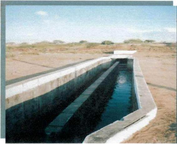
**Figura 22.** Vista da grade, caixa de areia e calha Parshall (Pré-tratamento) da ETE Catingueira de Campina Grande-PB
