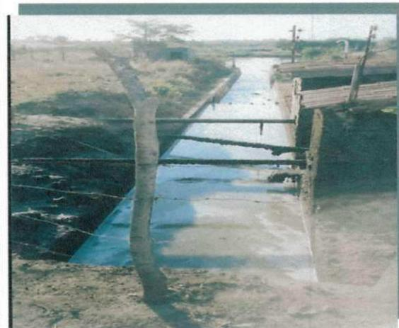
O efluente bruto antes de entrar na primeira lagoa passa por uma calha Parshall e uma grade, para conter a passagem de materiais sólidos de grande diâmetro. O efluente depois de passar pela 2ª lagoa desemboca no vertedouro de saída e vai alimentar plantios de milho, capim, tomate, pimentão e outras culturas.
