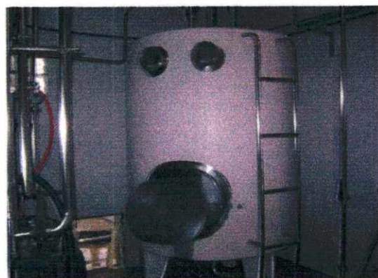
Fig. 12 - Tanque pulmão do laticínio Agroleite
