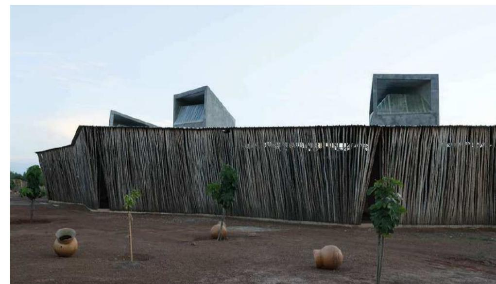
torres de ventilação de concreto que em conjunto com as diversas aberturas permitem ventilação cruzada em todos os ambientes (figura 26). Os bancos dispostos em todas as janelas, funcionam também como peitoril ventilado (figura 25) e além de captar ventilação, permitem seu resfriamento.
