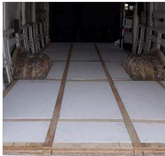
Figura 24: Isolamento termoacústico em EPS
