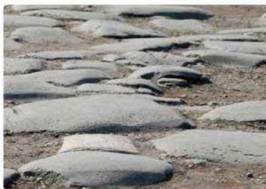
Figura 2 - Pavimento intertravado de pedras talhadas em forma de prisma regular.
