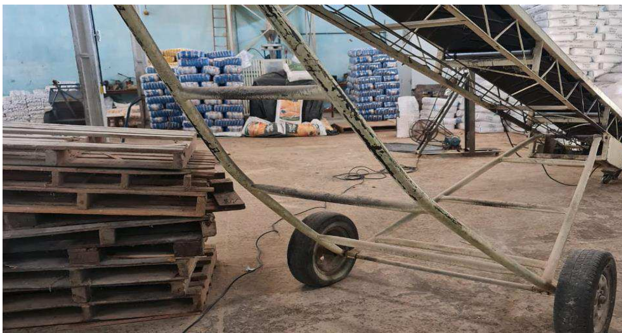
Figura 15 - Cabos elétricos da esteira dispostos em locais de trânsito.
