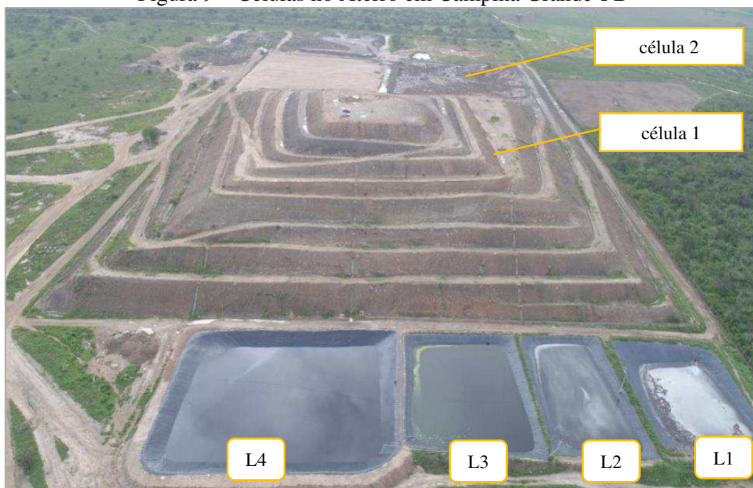
Figura 9 – Células no Aterro em Campina Grande-PB
