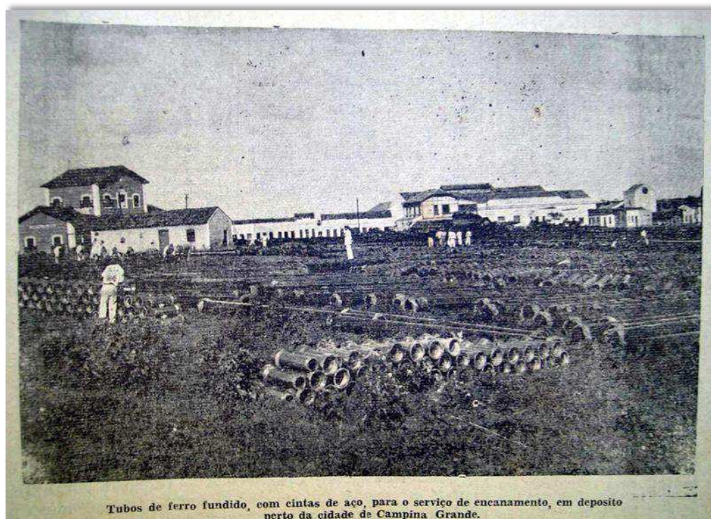
Figura 9: Tubos armazenados nas proximidades da Estação de Trens da GWBR (1937).
