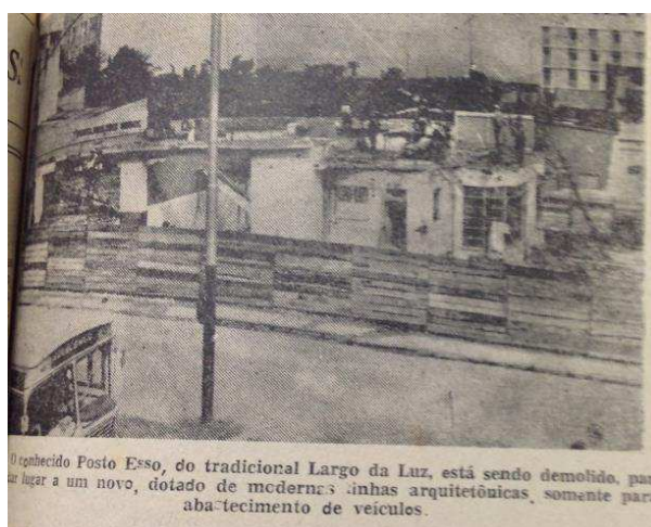
Figura 18: Posto Esso em demolição
