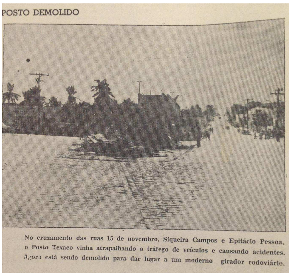
Figura 17: Posto Texaco em demolição
