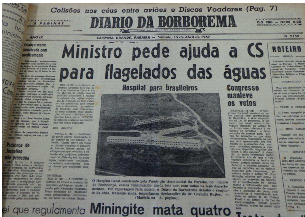
Figura 3- Finalização das obras da Fundação Assistencial da Paraíba-FAP
