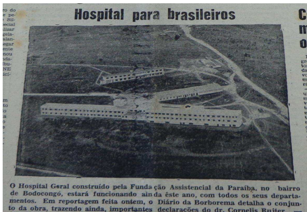
Foto 4- Finalização das obras do Hospital Fundação Assistencial da Paraíba-FAP
