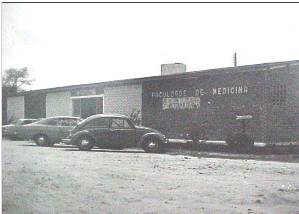
Foto 13- Prédio da Faculdade de Medicina (década de 1970)
