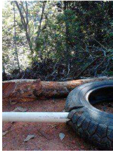
Figura 12: Tubo exaustor de gás (respiradouro)
