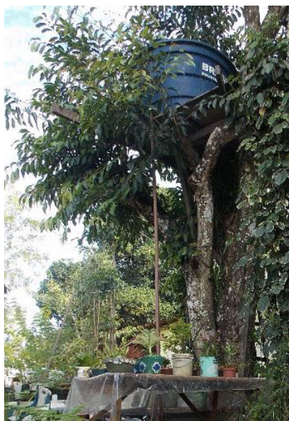
Figura 18: caixa d'água da casa
