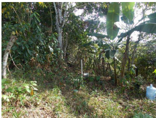
Figura 17: Fossa atualmente coberta por bananeiras
