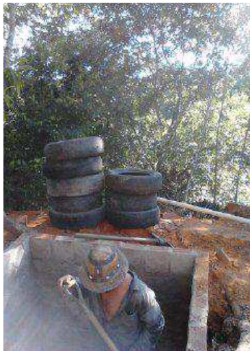
Figura 13 – Trabalhador montando a fossa.
