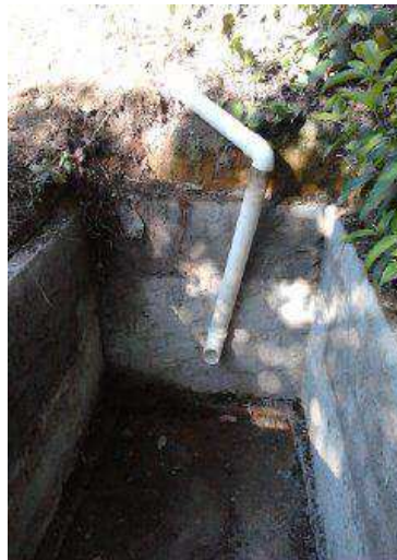
Figura 14 – Acabamento com concreto e argamassa.
