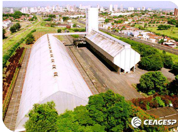
Figura 3(a) - Silo horizontal
