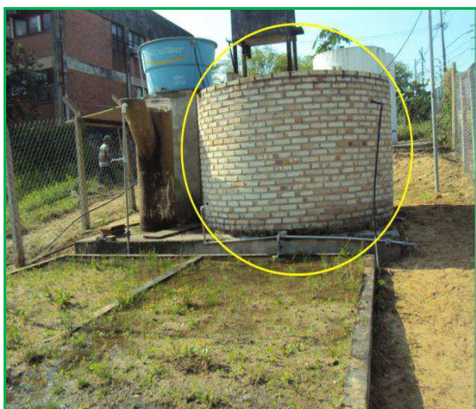
Figura 3. Reservatório com capacidade de armazenamento de 5.000L
