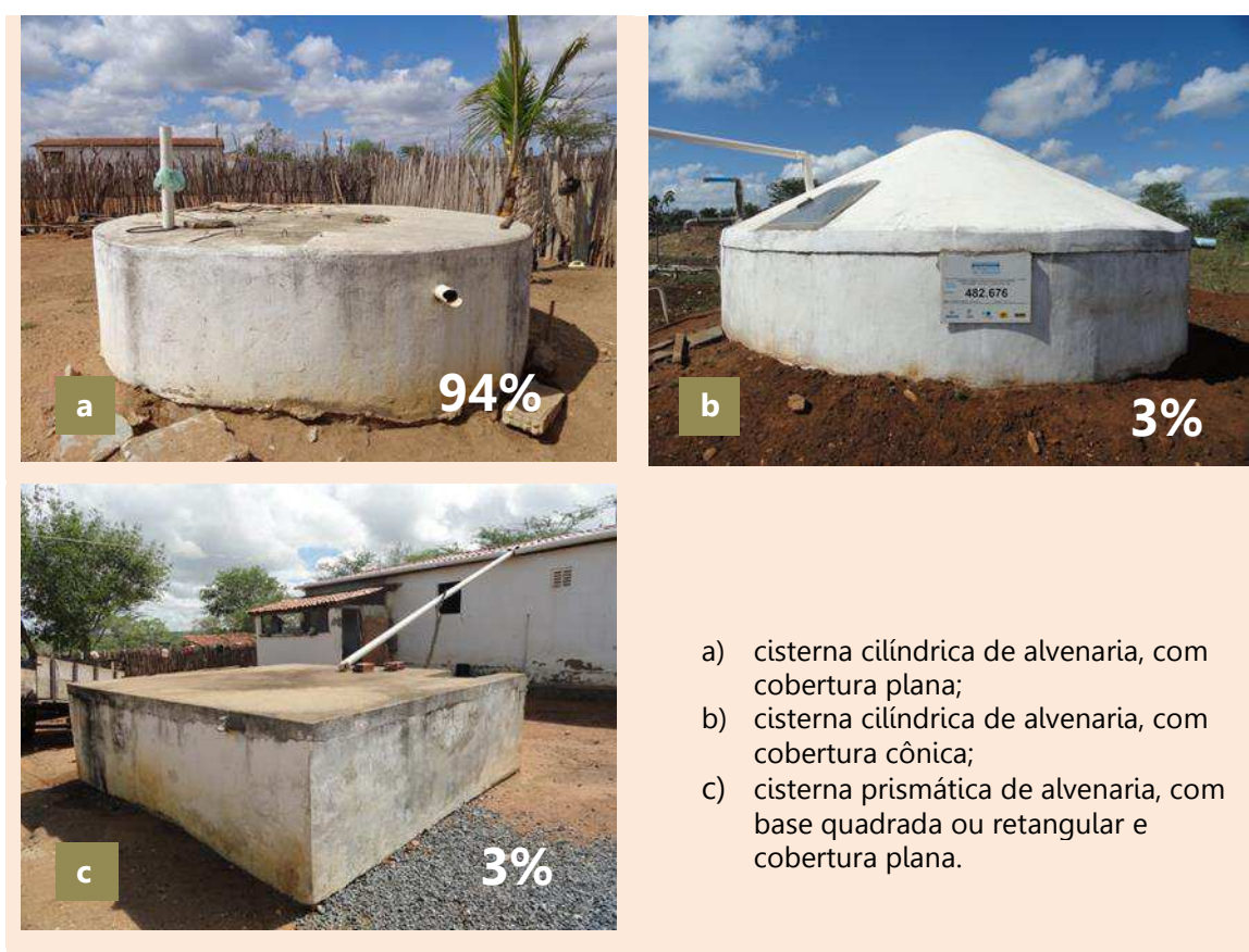
Figura 29 – Três modelos de cisterna de alvenaria encontrados na pesquisa
