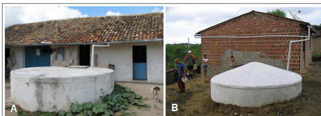
Figura 13 – Dois modelos de cisternas cilíndricas de placas: com cobertura plana (A); e com cobertura cônica (B).
