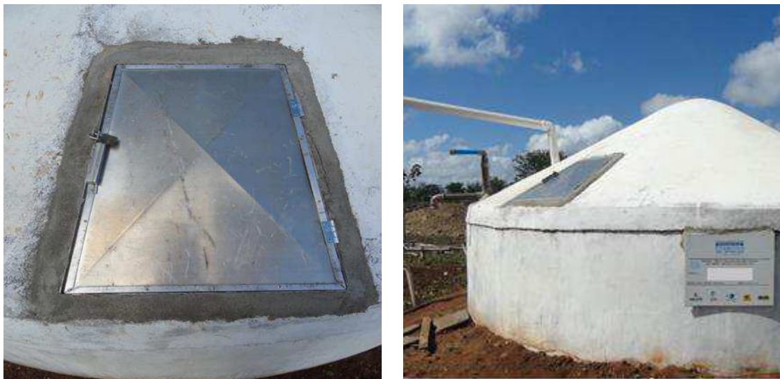
Figura 33 – Modelo de porta de visita em chapa de alumínio empregado nas cisternas construídas pelo P1MC.
