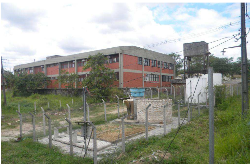
Figura 5 – Vista da estação de tratamento. Fonte: Arquivo pessoal.
