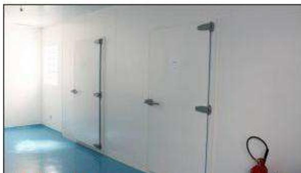
**FIGURA 2.17** : Pannel isotérmico com núcleo de EPS, revestido por chapas finas de zinco, pré-pintadas (ISOREVEST).
