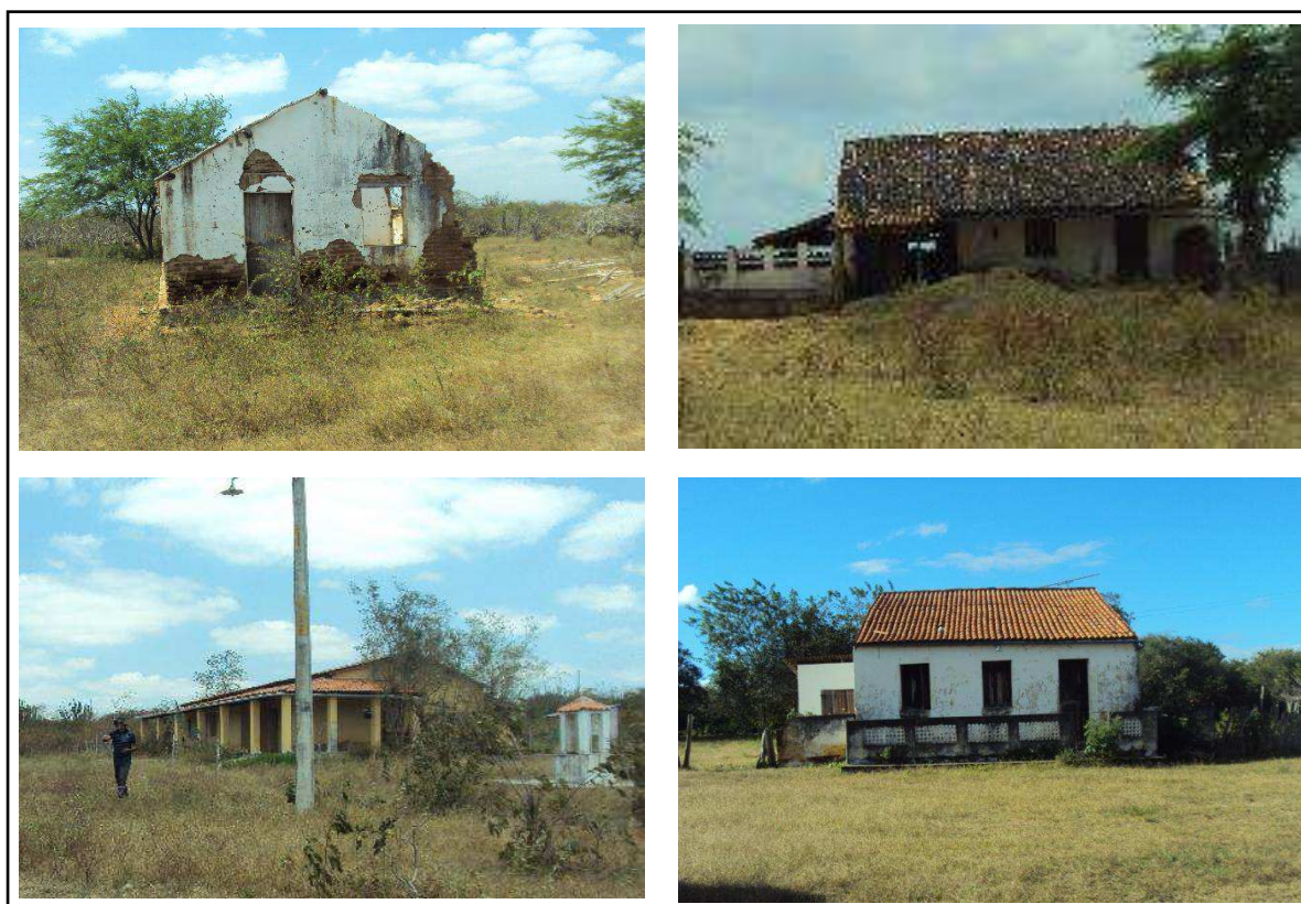
Figura 13 - Residências em ruína, sem condições de habitação ou abandonada na bacia hidrográfica do Açude Juá.
