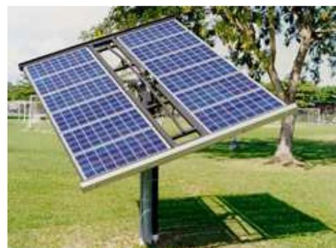
▲ Figura 15: Estrutura com seguidorsolar.
