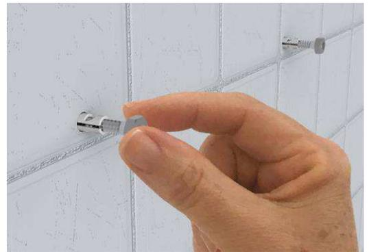
Figura 92: Mão da usuária fixando a bucha e o parafuso na parede
