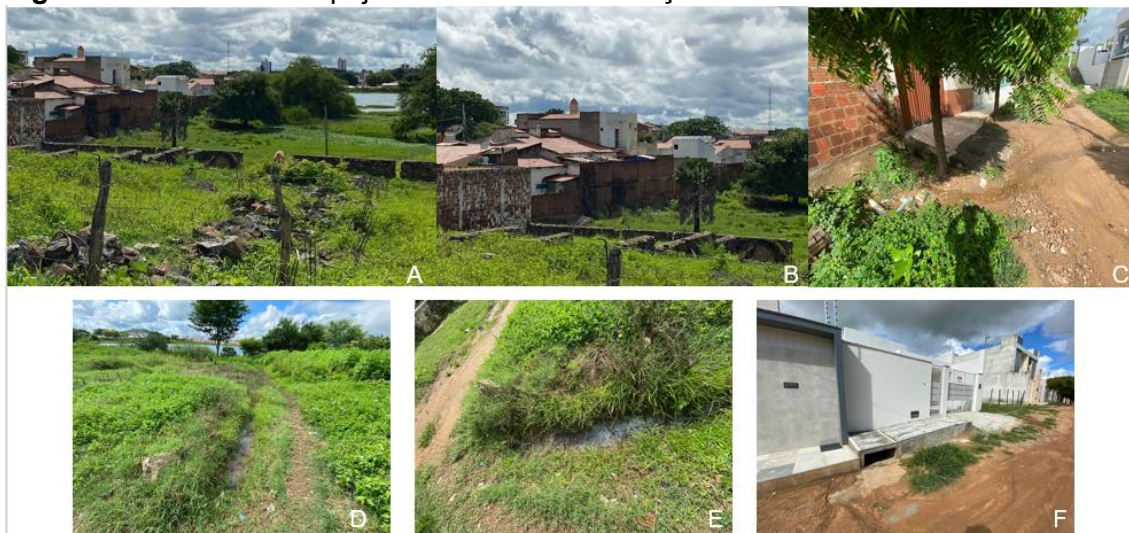
Figura 4 – Efluentes despejados diretamente no açude
