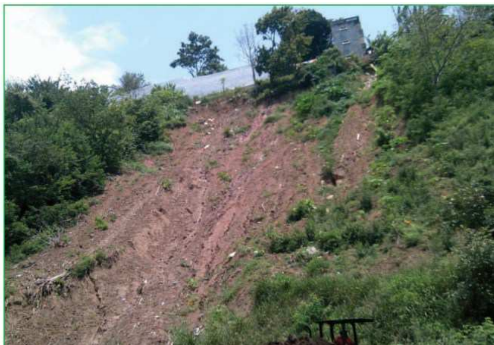
Figura 5-Deslizamento ocorrido em encosta no município de Areia - PB
