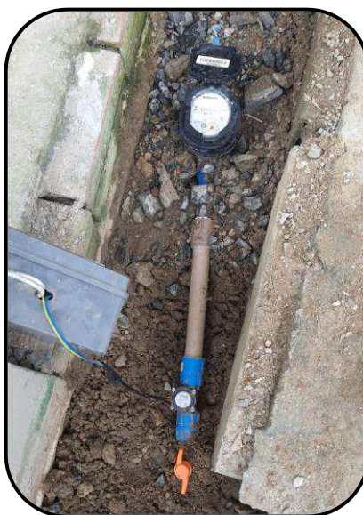
Figura 35 - Instalação do Hidrômetro IoT na horizontal e em série com o hidrômetro analógico
