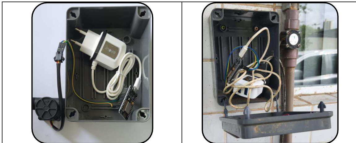
Figura 19 - Hidrômetro IoT final utilizado para medição do consumo de água
