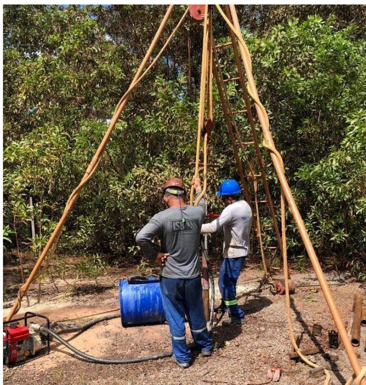
Figura 13. Registro da atividade de sondagem SPT no Porto do Itaqui.
