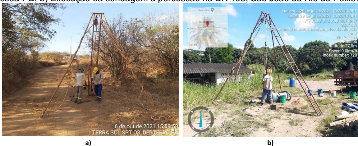
Figura 22. a) Execução da sondagem a percussão, no município de Desterro PB; b) Execução da sondagem a percussão para obras de engenharia em terreno pertencente ao Complexo Beira Rio, em João Pessoa-PB.
