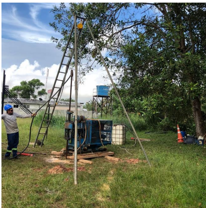
Figura 15. Registro da execução de sondagem rotativa no porto do Itaqui.
