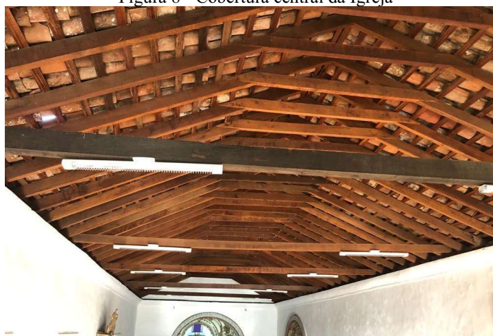
Figura 8 - Cobertura central da Igreja
