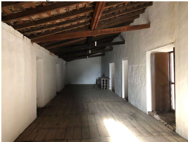
Figura 13 - Piso em assoalho de madeira
