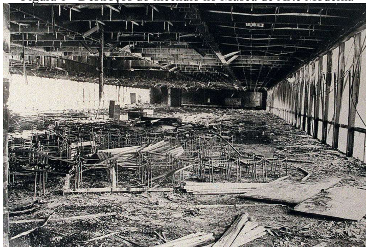
Figura 1 - Destroços do incêndio no Museu de Arte Moderna
