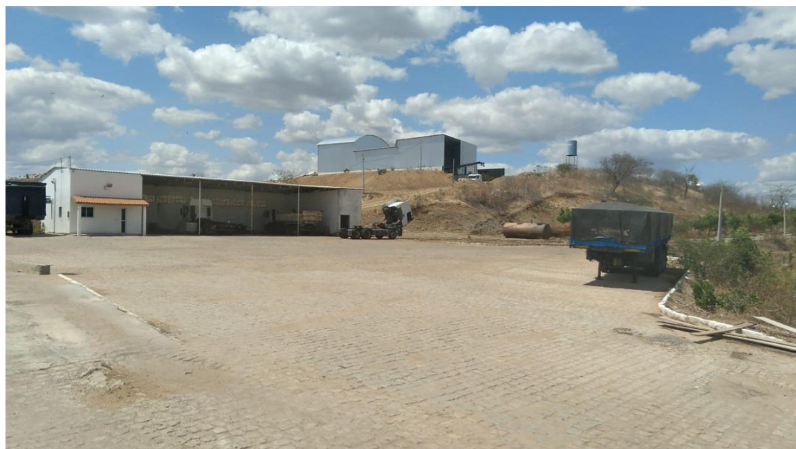
Figura 13 – galpão de triagem, garagem e administração
