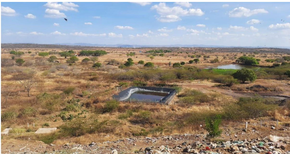
Figura 15 – lagoa de estabilização para onde são direcionados os chorumes
