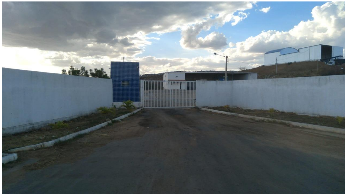
Figura 12 – entrada da UTR de Sousa-PB
