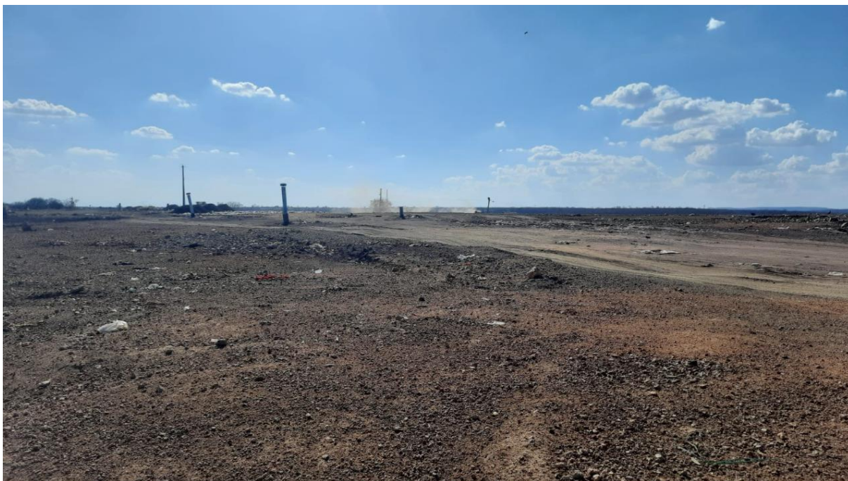
Figura 14 – célula da UTR onde são colocados os resíduos
