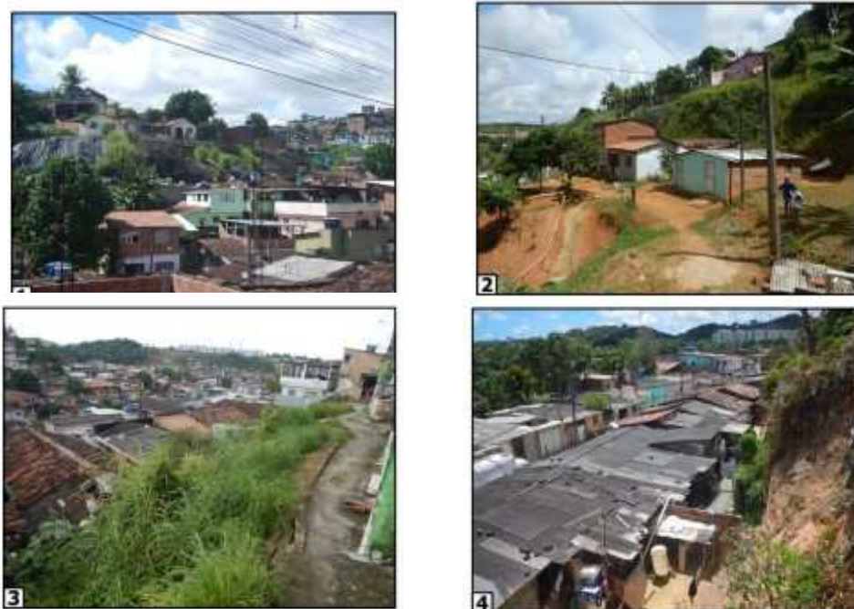
Figura 9. Residências construídas em áreas de riscos sujeitas a eventos de deslizamentos na cidade de Jaboaão dos Guararapes, Pernambuco. 1 – Centro, 2 – Engenho Velho, 3 – Cavaleiro, 4 – Curado. Fonte: CPRM.
