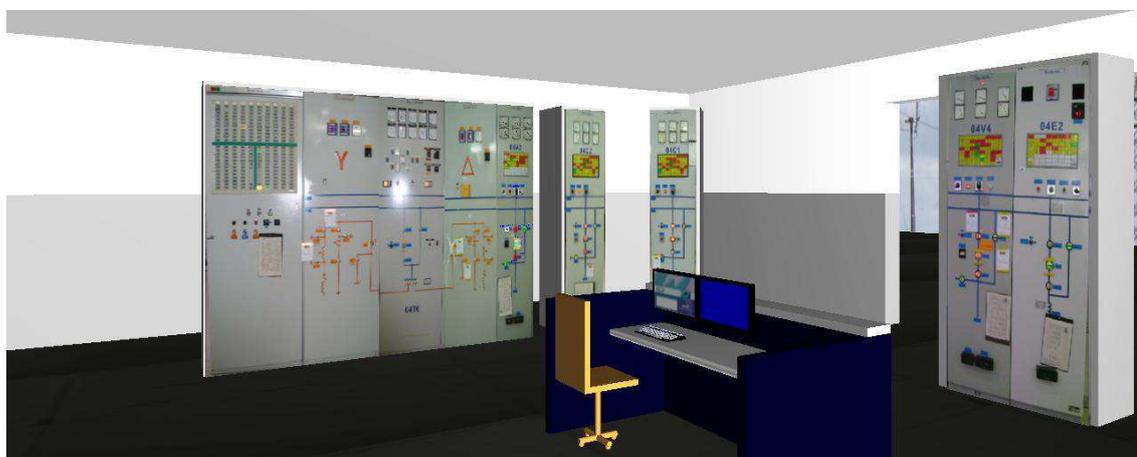
Figura 3-1 – Sala de controle virtual de uma subestação elétrica, representada no ambiente do simulador
