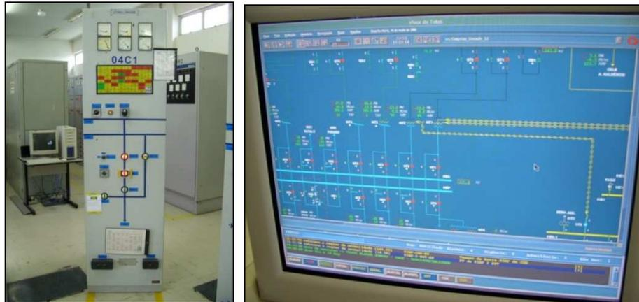
**Figura 3-5 – Painel de comando e tela do supervisório (Fonte: Subestação CHESF, Campina grande)**
