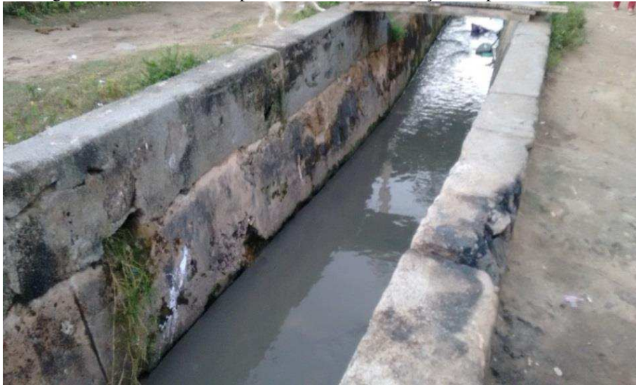
Figura 13 – Trecho onde a prefeitura iniciou a elevação das paredes do canal
