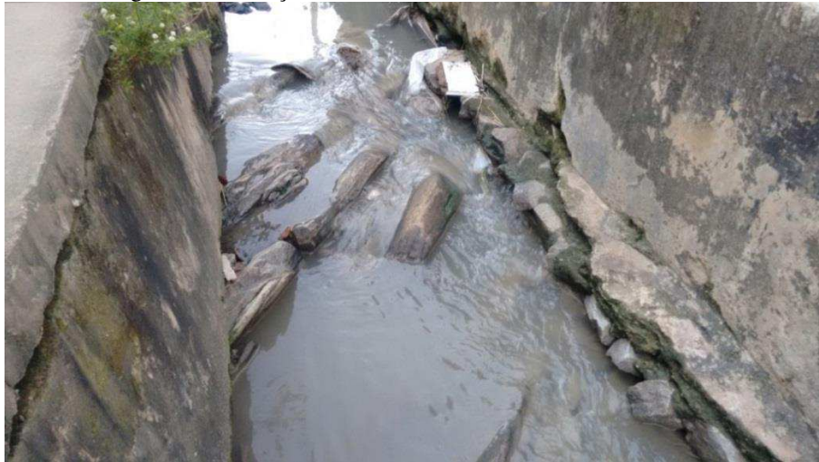
Figura 11 – Situação atual do leito do canal em um dos trechos
