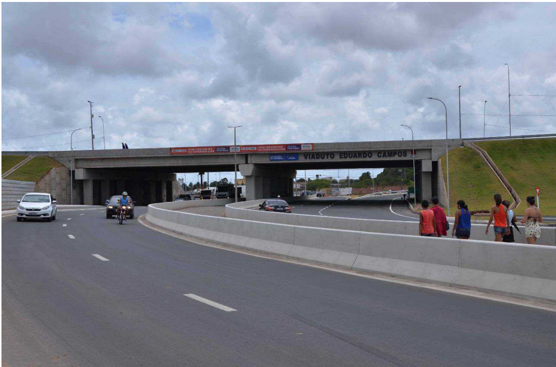
Figura 9 – Vista lateral do viaduto Eduardo Campos.
