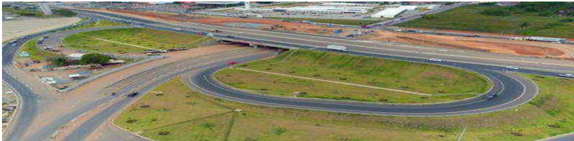
Figura 8 – Vista Superior do viaduto Eduardo Campos.
