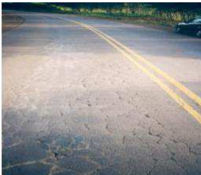
Figura 5: Trincas intercaladas
