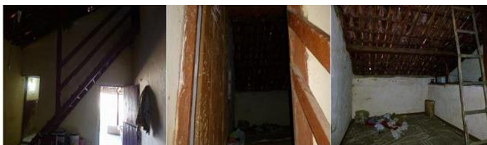
Figura 1- Acesso interno ao sótão e escadas
