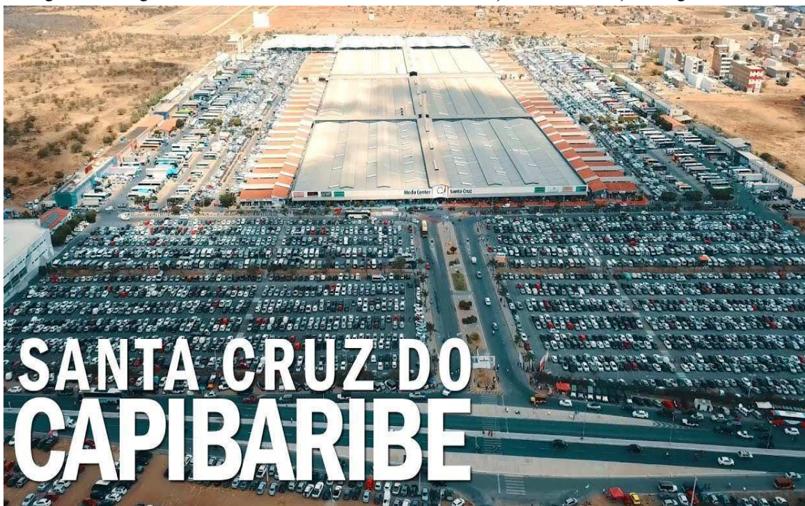
Figura 13: Imagem aérea do Moda Center Santa Cruz e do Calçadão de Confeccões Miguel Arraes
