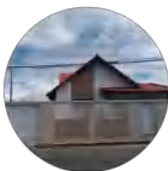
Fachada Rua Acre nota: 0,5
