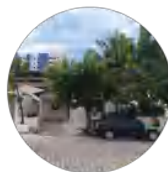
Fachada Rua Acre nota: 0,5
