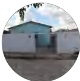
Fachada na Rua HBC nota: 0
