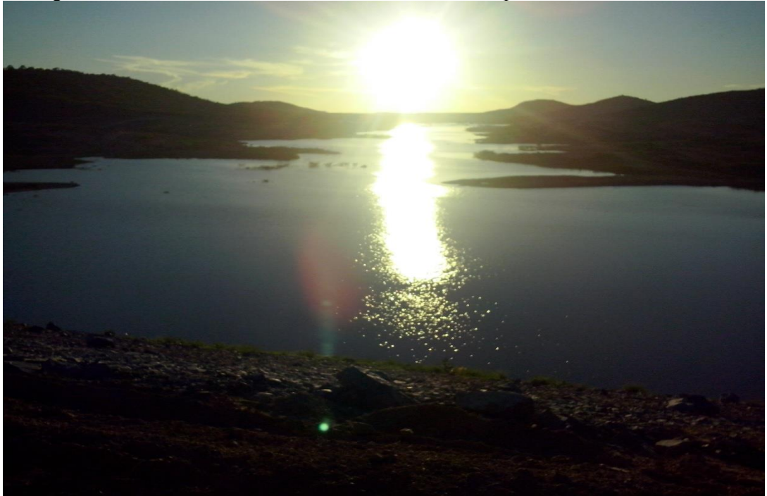
Figura 6 – Reservatório localizado em Boa vista, Município de São José de Piranhas
