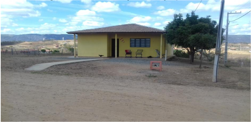
Figura 15 – Residência do Projeto de Transposição
