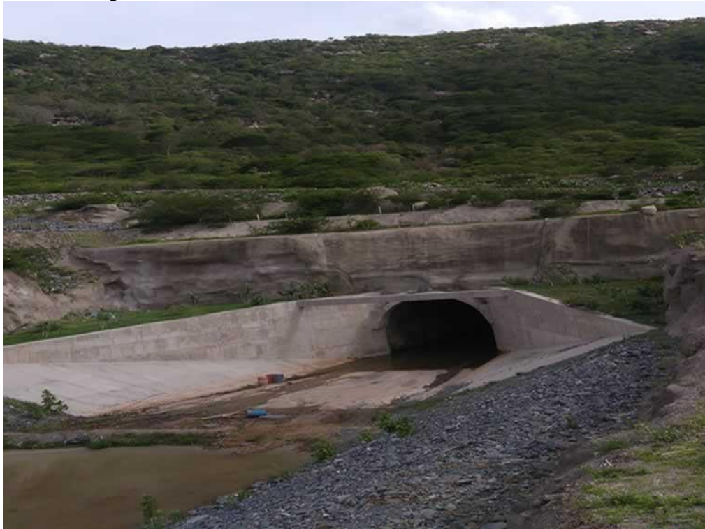
Figura 5 9 – Túnel Cuncas I, São José de Piranhas/PB Finalizado
