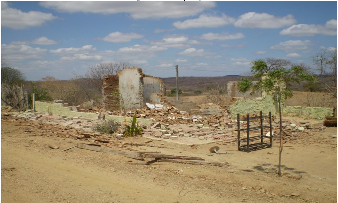
Figura 11 – Residências totalmente demolidas na comunidade rural do Sítio Cacaré para a execução do Projeto de Transposição
