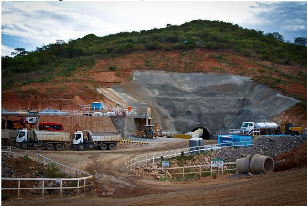
Figura 4 8 – Túnel Cuncas I, São José de Piranhas/PB
