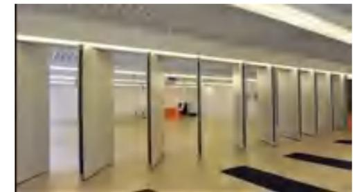
Figura 88: Exemplo de painéis acústicos retráteis
