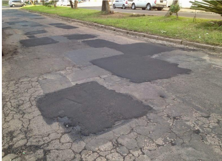
Figura 12: Remendo.
