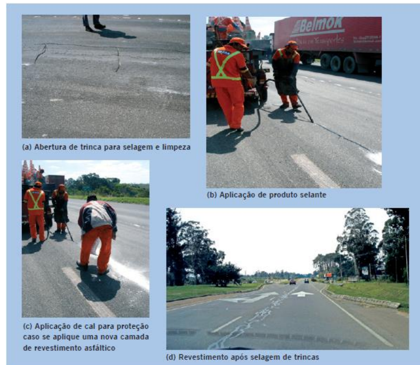
Figure 23: Tratamento por Selagem.
