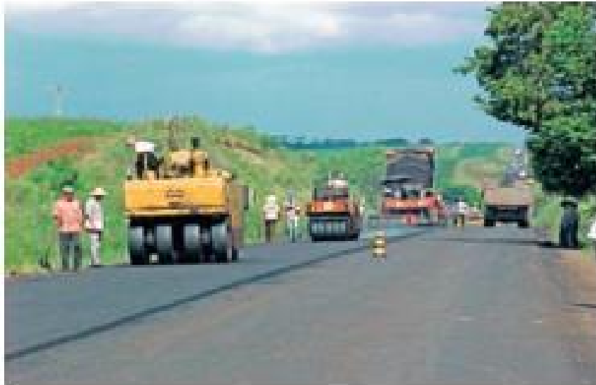
Figura 26: Processo de Recapeamento.
