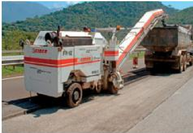
Figure 25: Remoção por Fresagem.
