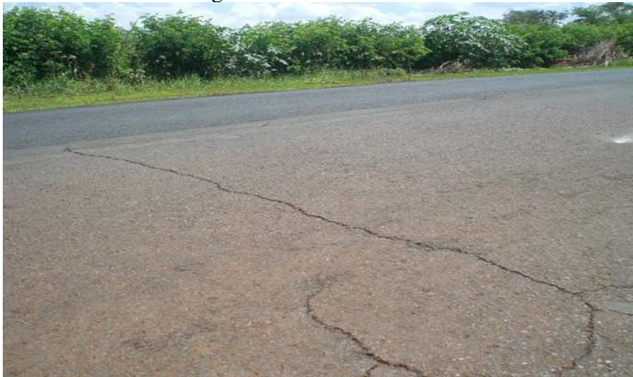
Figura 2: Trinca Transversal
