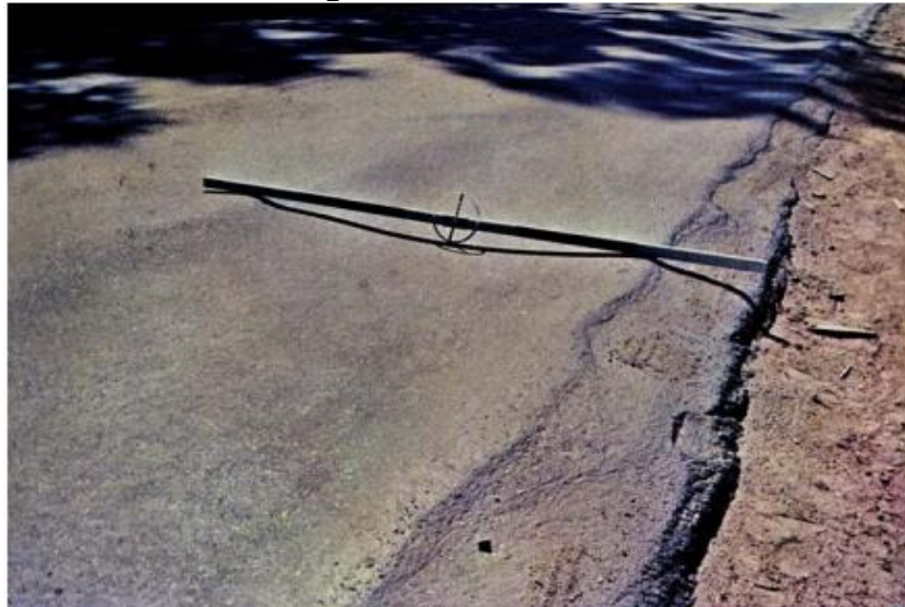
Figura 6: Afundamento
