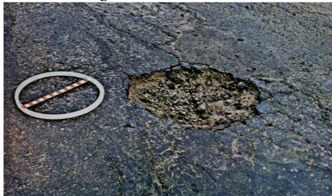
Figura 11: Panela/Buraco.
