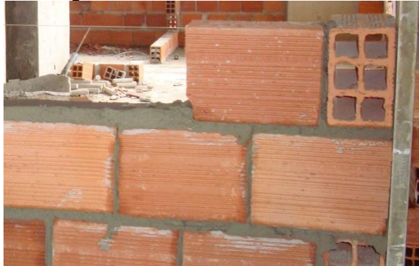
Figura 13: Assentamento de alvenaria
