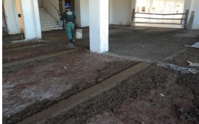
Figura 11: Execução das mestras do contrapiso
