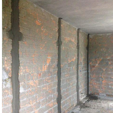
Figura 5: Execução das mestras do emboço
