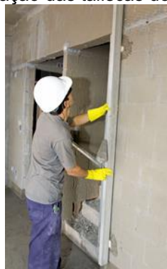
Figura 4: Colocação das taliscas do emboço
