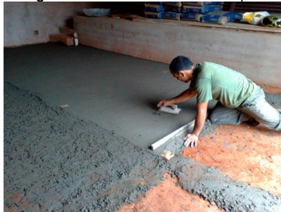
Figura 12: Sarrafeamento do contrapiso
