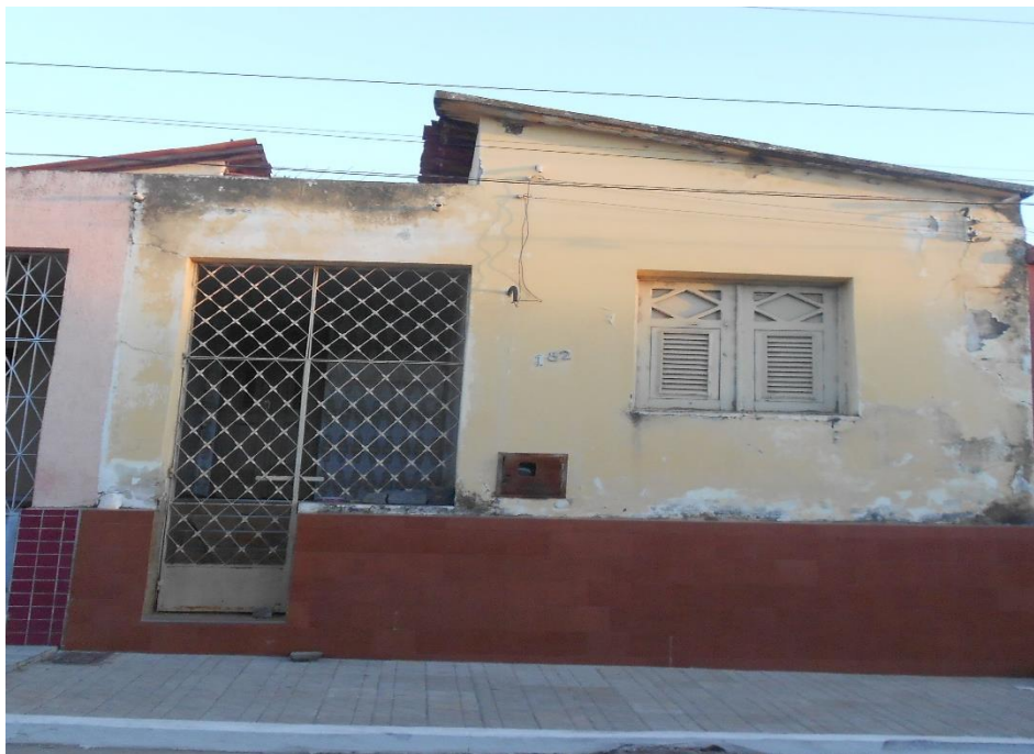
Casa nº 182, localizada na Rua Aprígio de Sá, fechada a mais de 13 anos, segundo informações dos vizinhos, casa de herdeiros.
