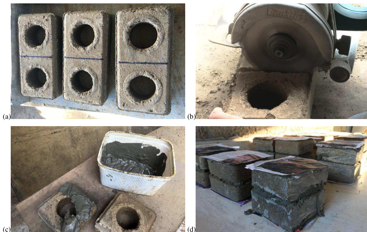
Figura 20 – (a) Marcação do corte central, (b) corte com serra elétrica, (c) colagem e (d) regularização de faces.
