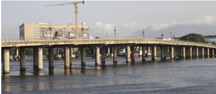
Figura 6: Concreto Protendido – Ponte do Galeão (RJ)
