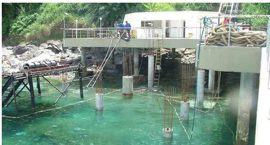
Figura 5: Concreto submerso - BELOV (Obras civis subaquáticas)
