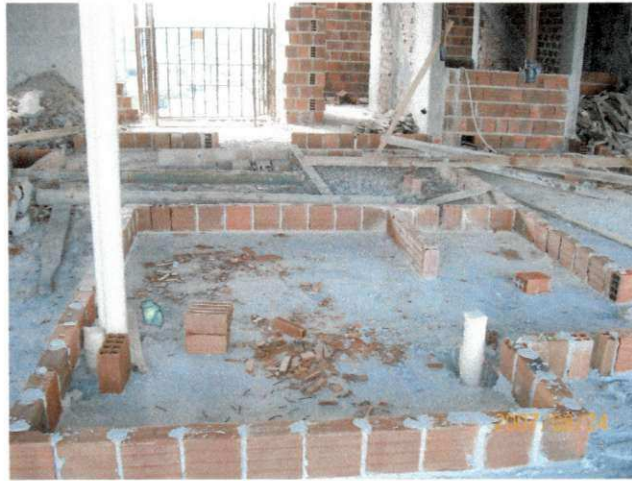
Foto A3. Levantamento de alvenaria.
