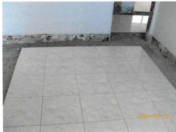
Foto A4. Assentamento de piso cerâmico.
