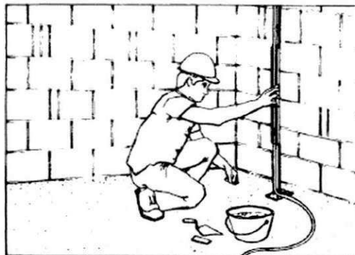
Figura 09. Aparelho de nível e assentamento de talisca empregando-se o aparelho de nível.
