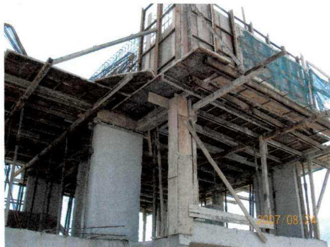
Foto A1. Detalhe do escoramento para confecção da caixa d'água
