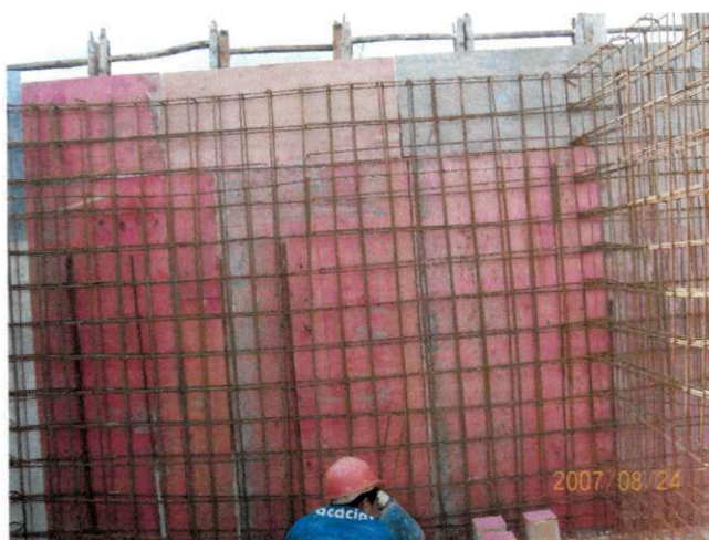
Foto A2. Confecção das ferragens da caixa d'água.
