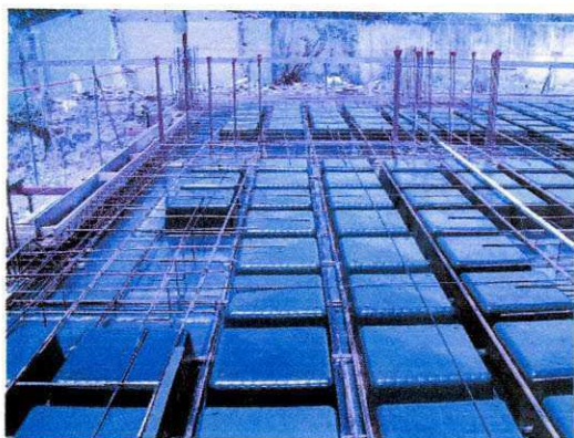
Figura 53. Ferragem das lajes e vigas. Figura 54. Ferragem das lajes e vigas.
