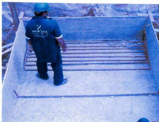
Figura 26. Ferragem das sapatas.
