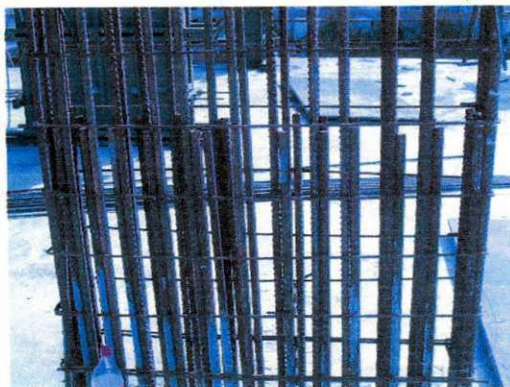
Figura 37. Ferragem dos pilares.
