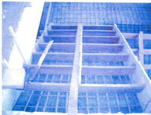
Figura 65. Fôrmas das escadas.
