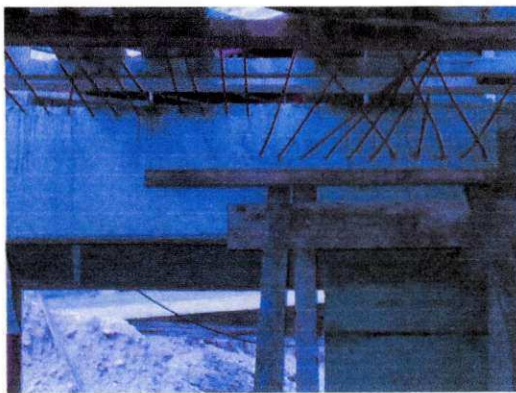
Figura 60. Fôrmas das escadas.
