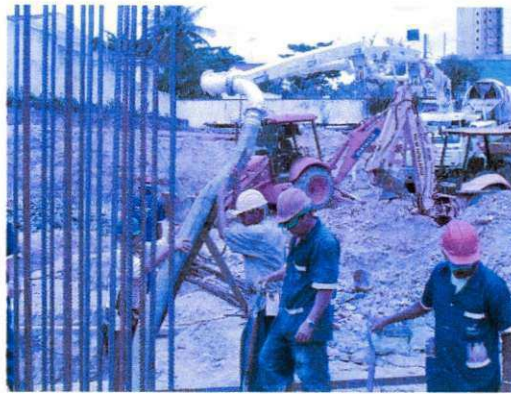
Figura 31. Concretagem das sapatas.
