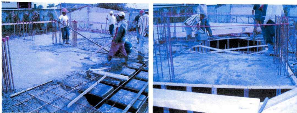
Figura 57. Concretagem das lajes e vigas. Figura 58. Concretagem das lajes e vigas.
