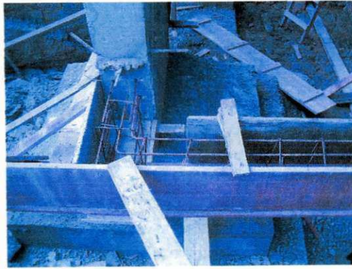
Figura 49. Armação das lajes e vigas.
