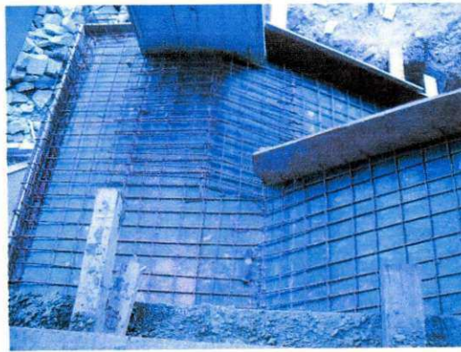
Figura 69. Ferragem das escadas.
