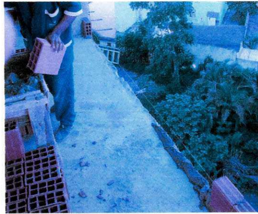
Figura 71. Alvenaria de tijolos.
