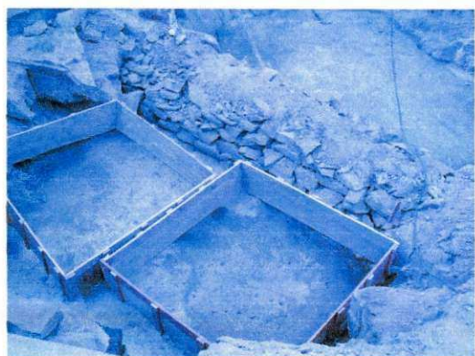
Figura 24. Armação das fôrmas.
