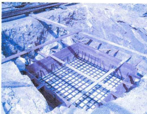
Figura 27. Ferragem das sapatas.
