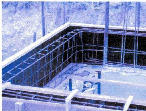
Figura 52. Ferragem das lajes e vigas.
