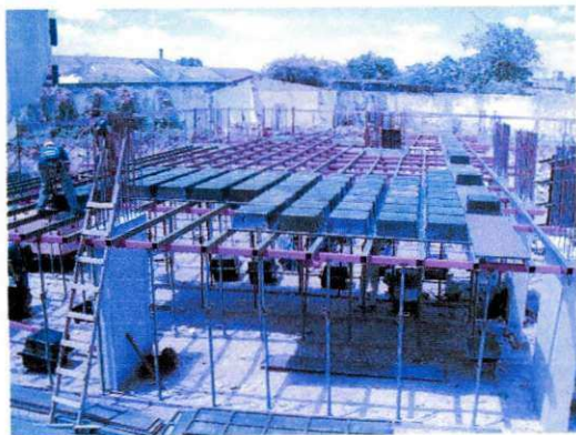
Figura 48. Armação das lajes e vigas.
