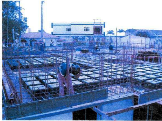
Figura 50. Armadura das lajes e vigas.
