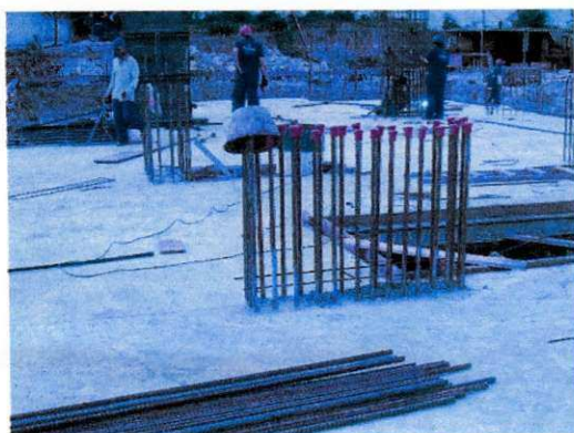
Figura 36. Ferragem dos pilares.
