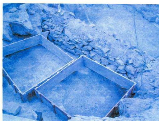
Figura 22. Nivelamento com concreto ciclópico. Figura 23. Nivelamento para armação das sapatas
