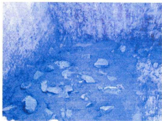
Figura 22. Nivelamento com concreto ciclópico. Figura 23. Nivelamento para armação das sapatas
