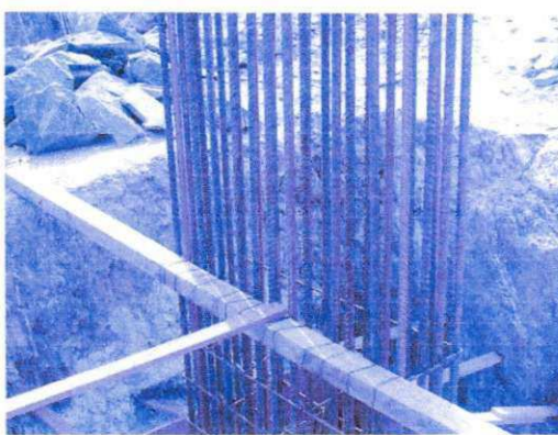
Figura 29. Ferragem das sapatas e pilares.
