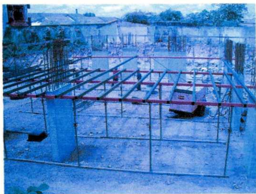
Figura 46. Armação das lajes e vigas.
