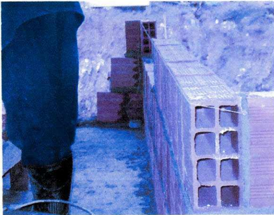
Figura 70. Alvenaria de tijolos.
