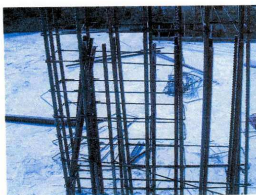
Figura 38. Ferragem dos pilares.
