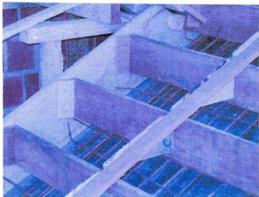
Figura 64. Fôrmas das escadas.
