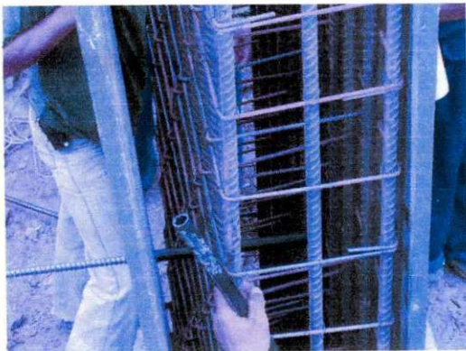
Figura 42. Colocação das fôrmas.
