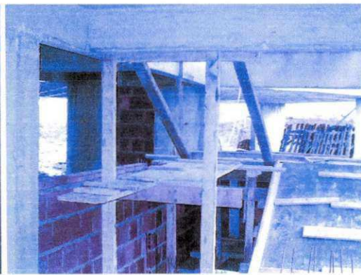
Figura 61. Fôrmas das escadas.
