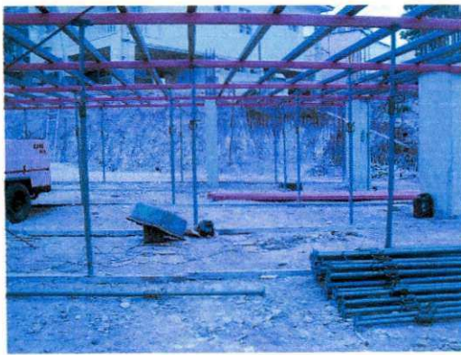
Figura 47. Armação das lajes e vigas.
