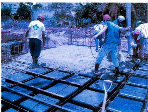
Figura 55. Concretagem das lajes e vigas. Figura 56. Concretagem das lajes e vigas.
