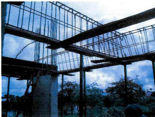
Figura 51. Ferragem das lajes e vigas.
