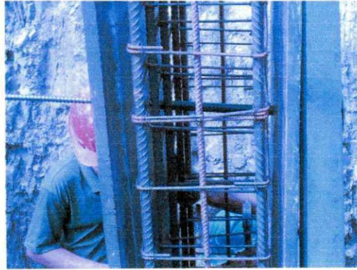
Figura 41. Colocação das fôrmas.
