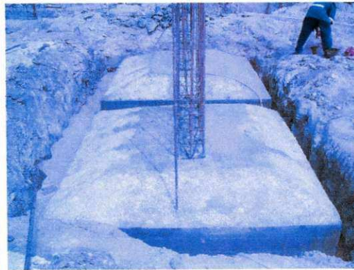
Figura 35. Retirada das fôrmas.
