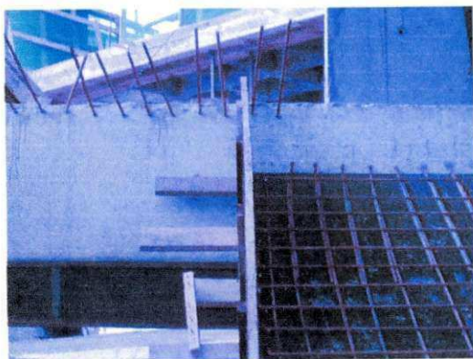
Figura 68. Ferragem das escadas.
