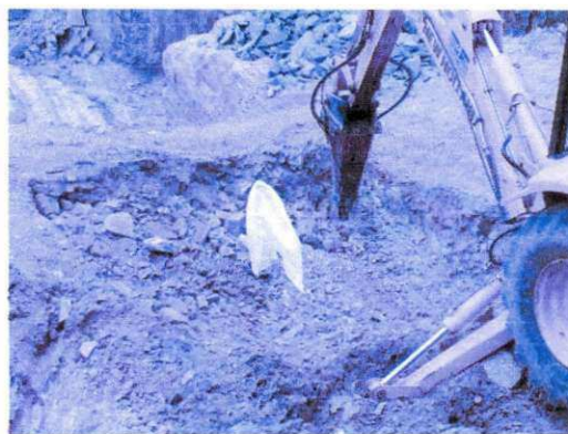
Figura 19. Escavação com picão.
