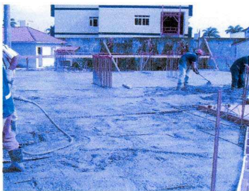
Figura 55. Concretagem das lajes e vigas. Figura 56. Concretagem das lajes e vigas.
