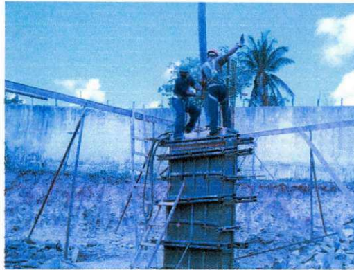
Figura 44. Concretagem dos pilares.
