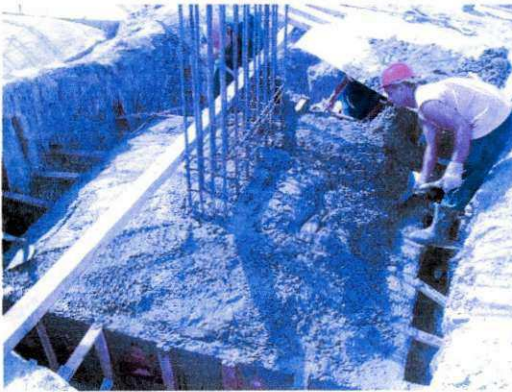
Figura 32. Concretagem das sapatas.
