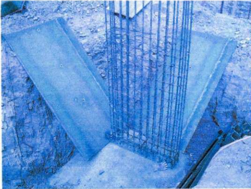
Figura 40. Colocação das fôrmas.
