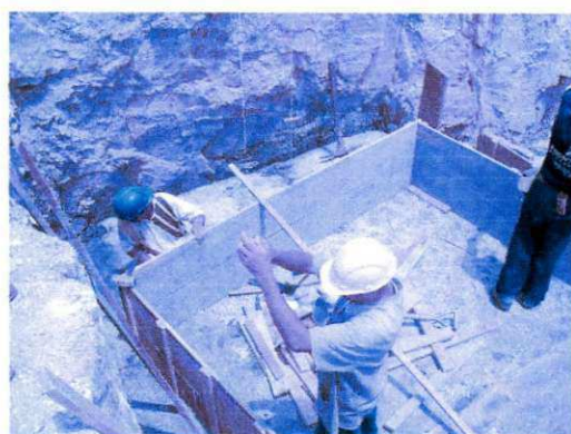
Figura 25. armação das fôrmas com utilização de prumo piquete.
