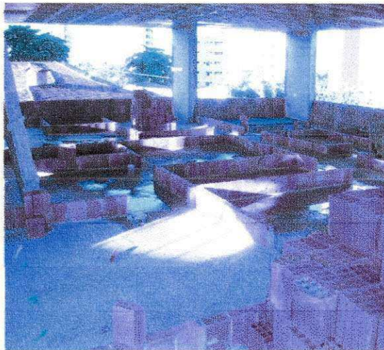
Figura 79. Demarcação da alvenaria.
