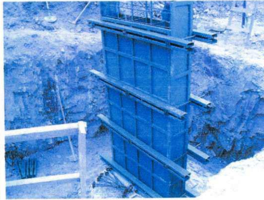
Figura 43. Colocação das fôrmas.
