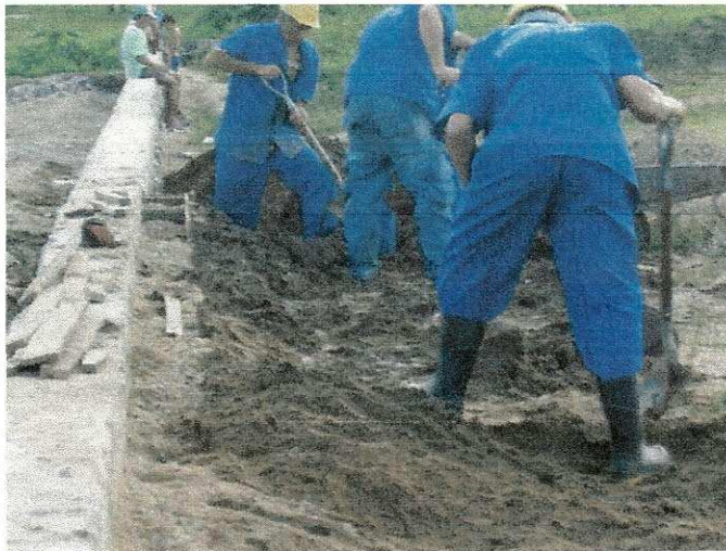
FOTO 28 – Fechamento dos drenos nos muros de arrimo
