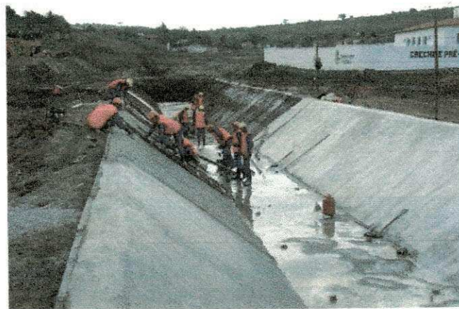
FOTO 11 – Canal de Macro Drenagem
