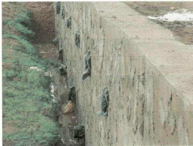
FOTO 27 – Muros de arrimo
