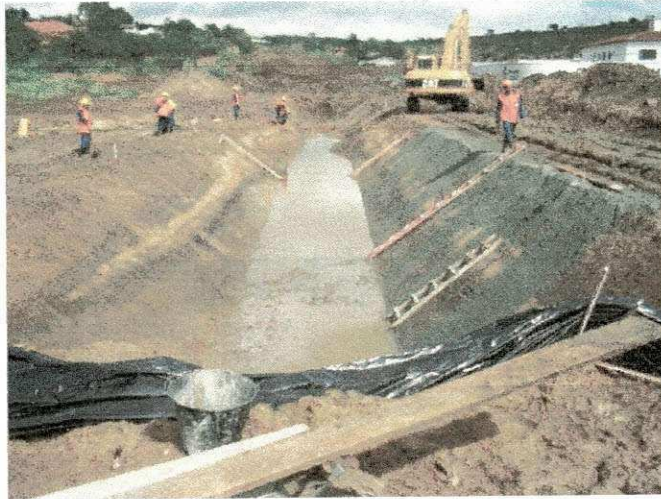
FOTO 10 – Canal de Macro Drenagem
