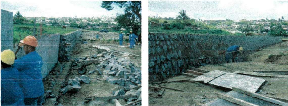
Foto 8 e 9 – Muros de Arrimo
