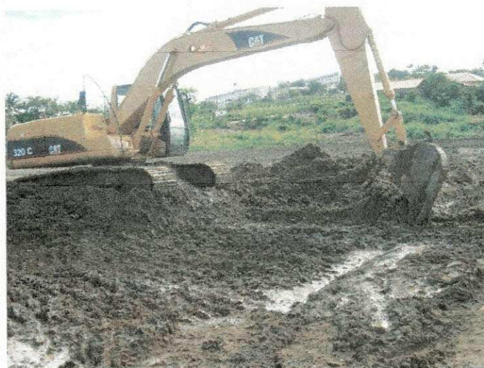
FOTO 17 - Escavação mecânica em lama
