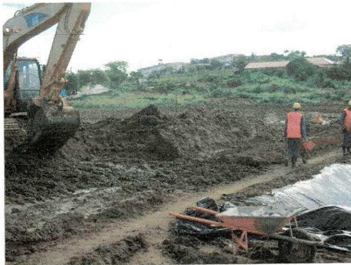
FOTO 16 - Escavação mecânica em lama
