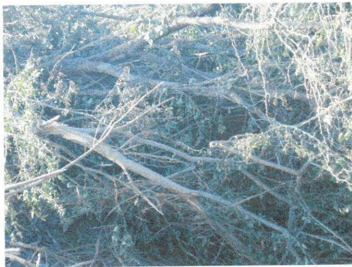
FOTO 14 - Desmatamento, destocamento e limpeza
