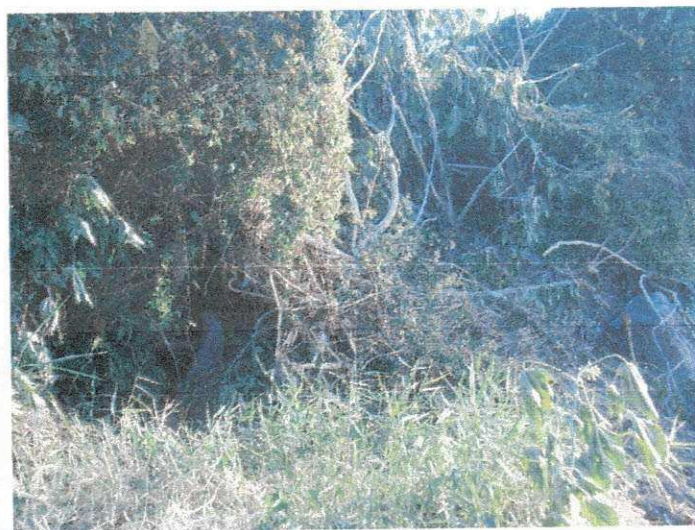
FOTO 15 - Desmatamento, destocamento e limpeza
