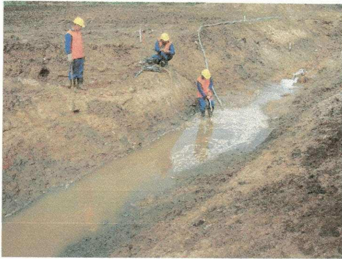
FOTO 22 – Esgotamento dos canais
