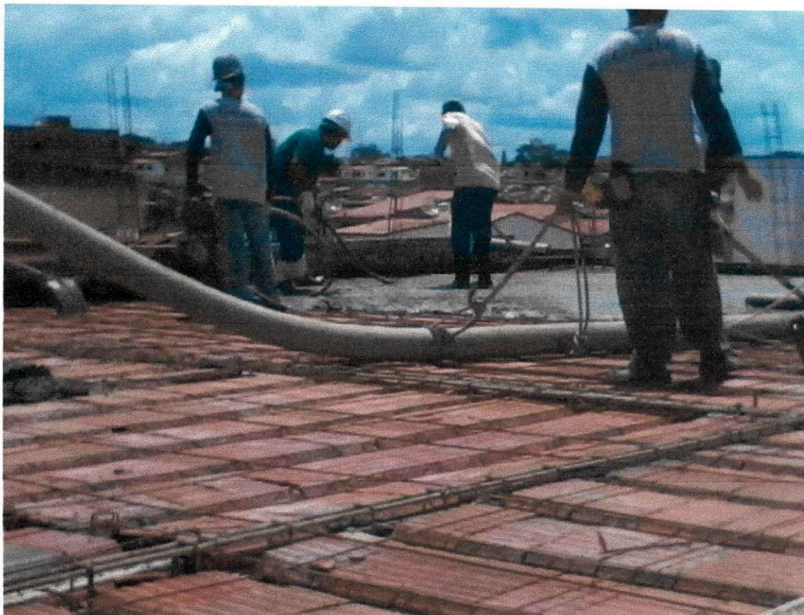
Figura 4 – Concretagem da laje.
