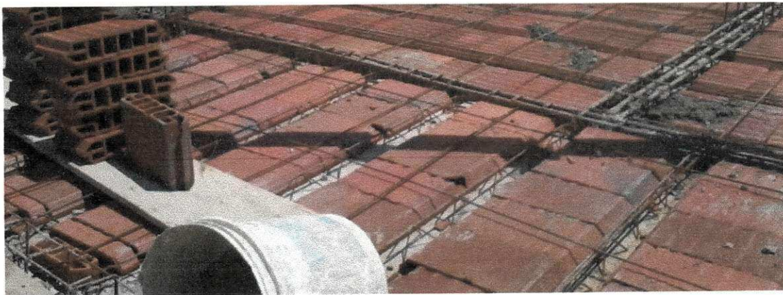
Figura 2 – Armadura da laje e das vigas.
