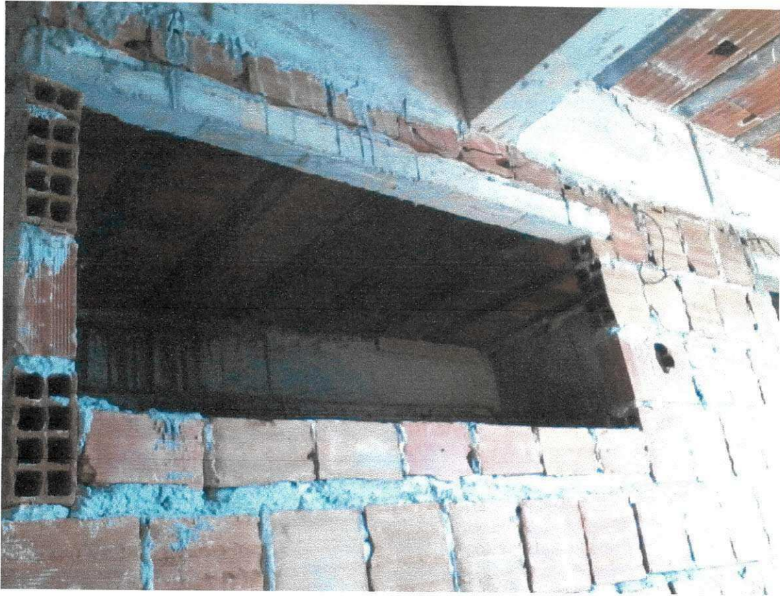
Figura 5 – Verga em vão de janela.
