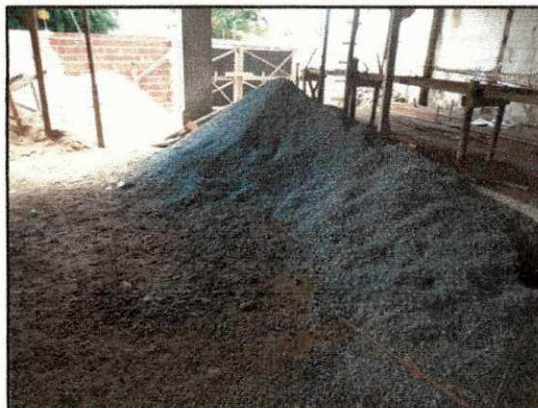
Figura 85 – Armazenamento de brita.
