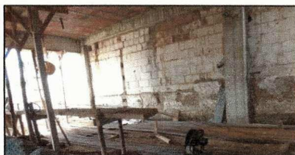
Figura 83 – Mesa para corte e dobra do aço.
