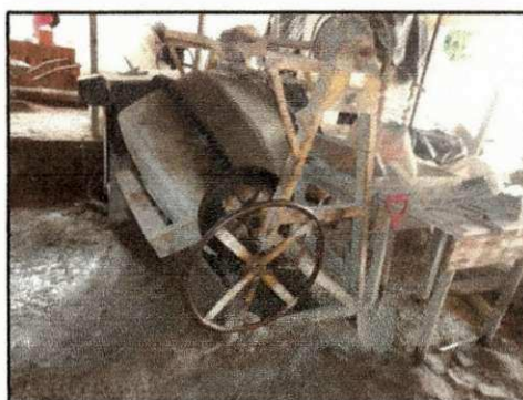
Figura 66 – Betoneira de 580 litros utilizada na obra.
