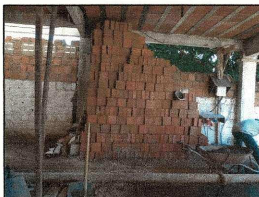
Figura 87 – Armazenamento de tijolos no depósito.
