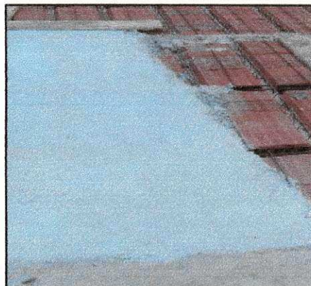
Figura 67 – Laje treliçada em execução na obra.
