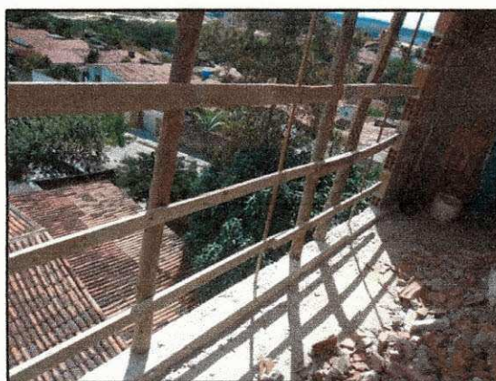
Figura 72 – Proteção da área aberta nas periferias da edificação.
