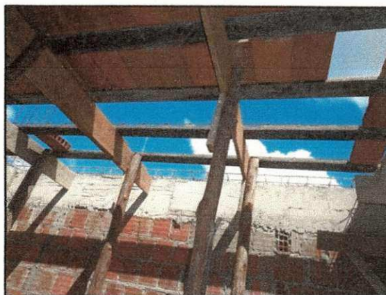
Figura 73 – Escoramento das lajes.
