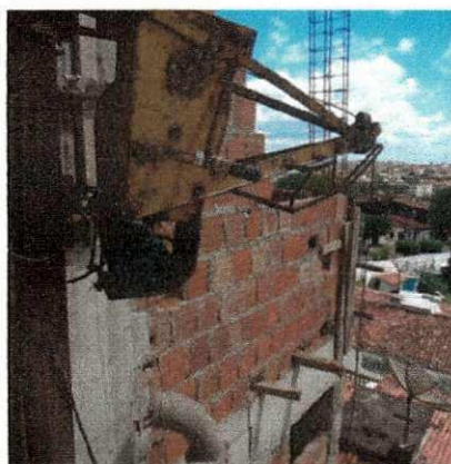
Figura 76 – Guincho utilizado na obra.
