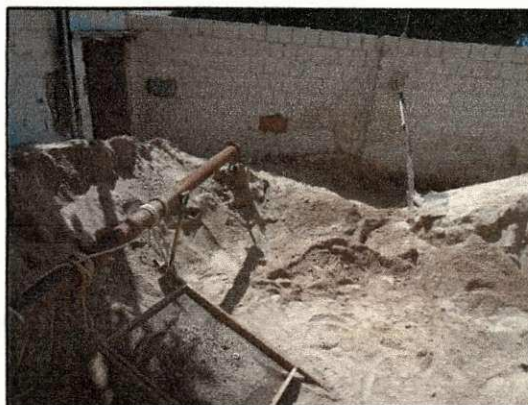
Figura 84 – Armazenamento da areia, separados em peneirados e não peneirados.
