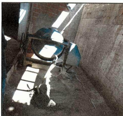
Figura 81 – Betoneira menor, de 400 litros, para mistura de argamassa.
