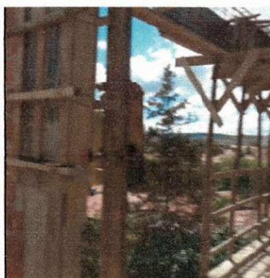
Figura 74 – Escoramento e fôrma de viga.
