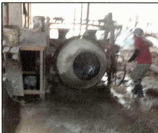
Figura 80 – Betoneira maior, de 580 litros, para mistura de componentes de concreto.
