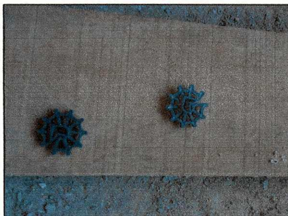
Figura 68 – Espaçadores plásticos que garantem cobertura mínima.
