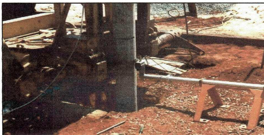
Figura 17 – Cravação de estaca pré-moldada (Fonte: Google imagens).
