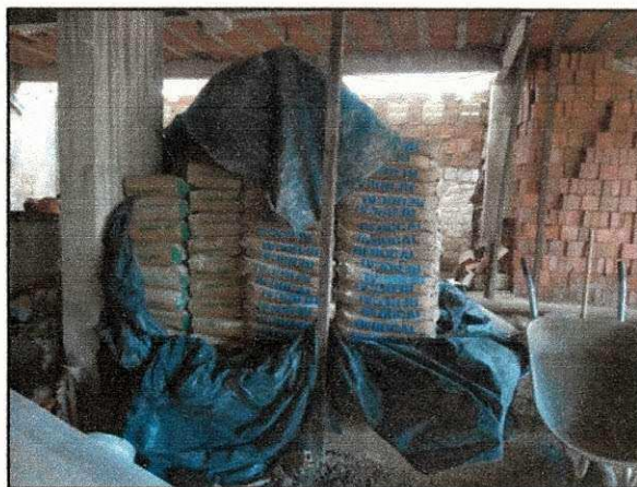
Figura 86 – Armazenamento de cimento e argamassa em depósito, com proteção.
