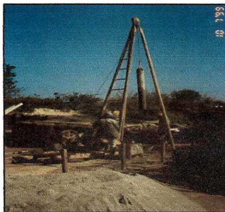
Figura 16 – Execução de estaca apiloada (Fonte: Google Imagens).
