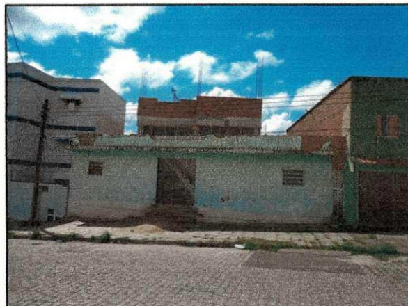
Figura 69 – Parte da frente da obra para entrada de operários.
