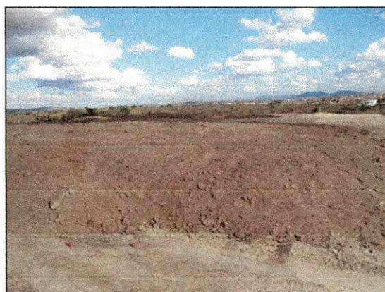
Área da segunda detonação na área de escavação 01. (imagem de 02/12)
