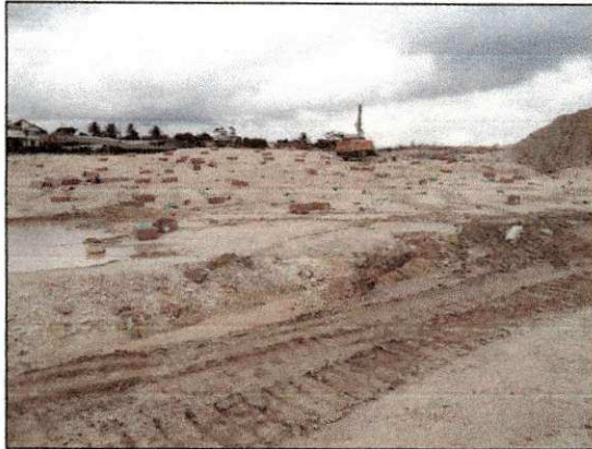
Carregamento de explosivos para a 5ª detonação. (imagem de 19/02/14)
