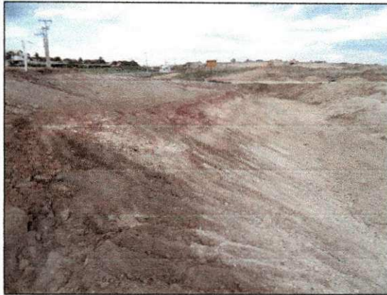
Taludamento executado em frente ao platô 06. (imagem de 14/11)
