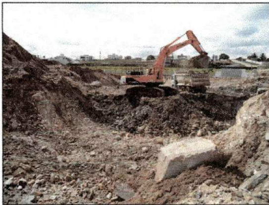
Continuação da retirada de material proveniente da 3ª e 4ª detonações. (imagem de 07/02/14)
