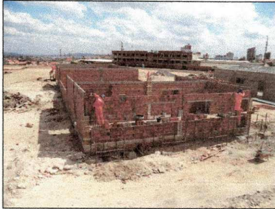
Execução da alvenaria de elevação e das cintas superiores do bloco do almoxarifado. (imagem de 05/12)
