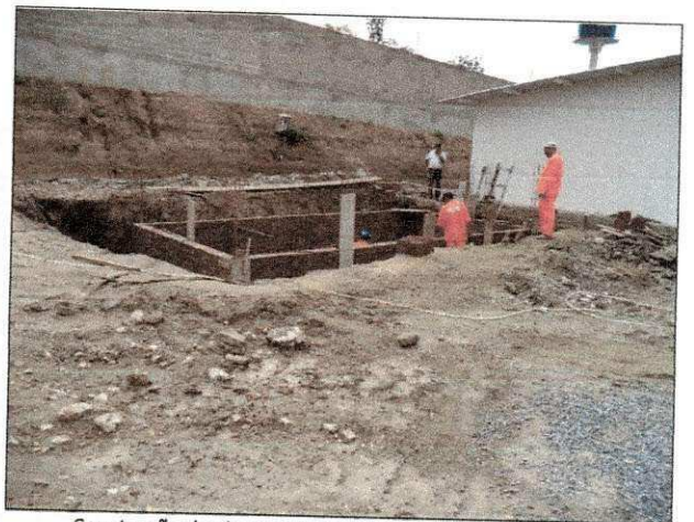
Construção de cisterna ao lado do bloco administrativo.
