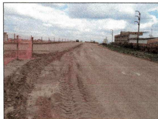
Acesso à obra regularizado com o auxílio de motoniveladora. (imagem de 14/01/14)
