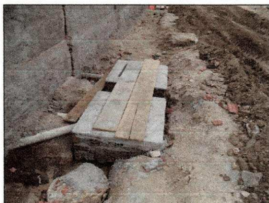
Execução de caixas de inspeção nos blocos operacionais. (imagem de 24/12)
