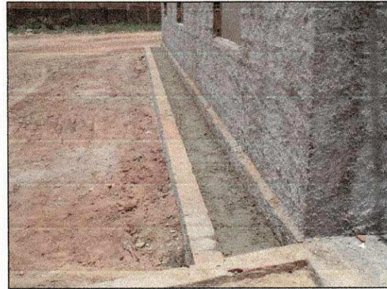
Execução da calçada de contorno do bloco administrativo. (imagem de 26/02/14)
