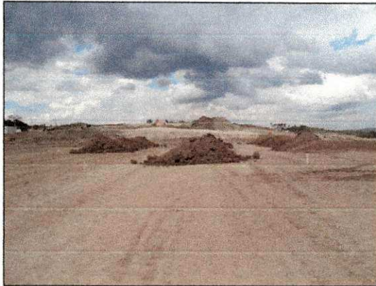
Lançamento de material no platô frontal do shopping. (imagem de 13/02/14)
