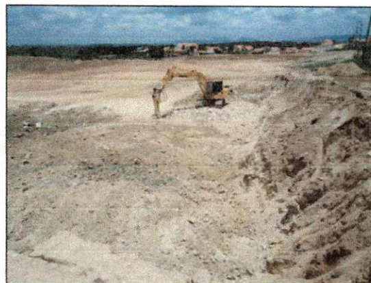
Desmonte de rocha branda na área de corte da cortina com auxílio de rompedor hidráulico da RealMaq. (imagem de 18/10)
