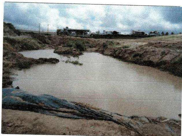
Execução da 3ª barragem de contenção da água para continuidade da execução do dreno.
