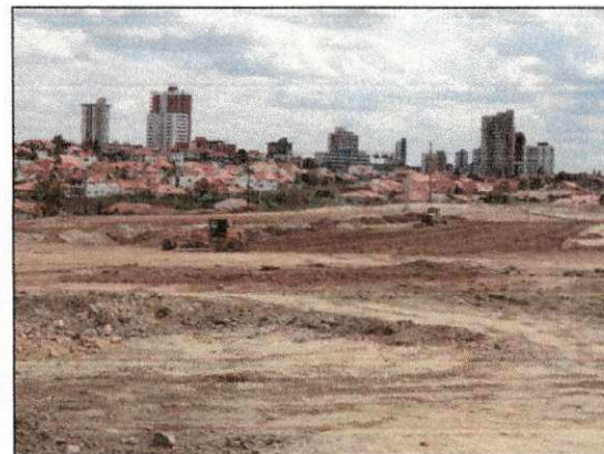
Espalhamento de material sobre a área da antiga lagoa. (imagem de 29/01/14)
