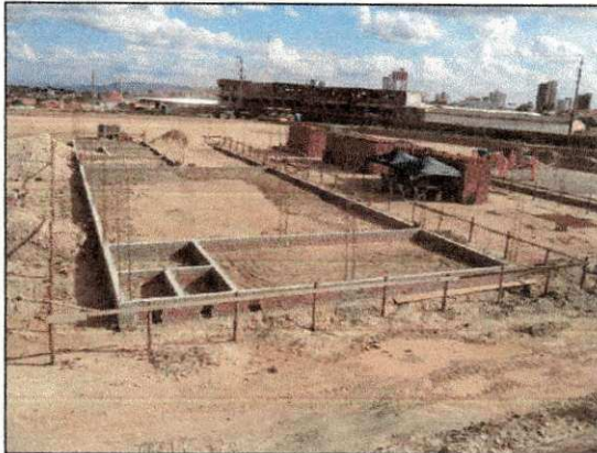
Conclusão da alvenaria de embasamento com tijolos de 1 vez e início do aterro do caixão do bloco do almoarifado. (imagem de 08/11)
