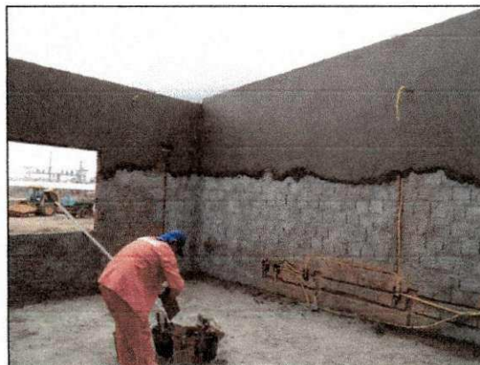
Execução da massa única e da instalação elétrica do bloco administrativo 02. (imagem de 19/02/14)
