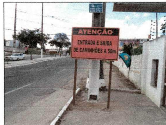
Instalação de placas de advertência nas vias próximas à obra. (imagem de 20/11)
