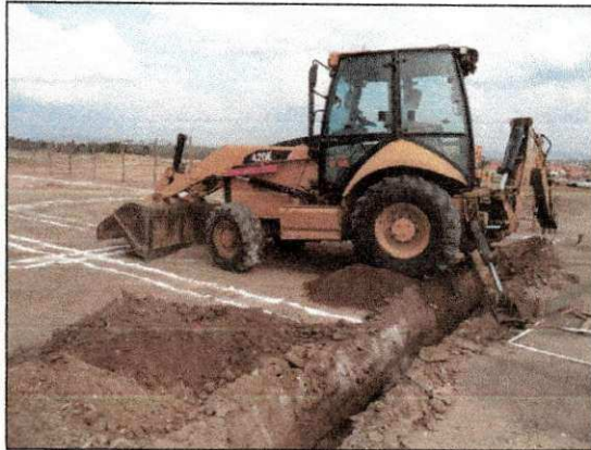
Escavação de vala mecanizada com auxílio de retroscavadeira. (17/01/14)
