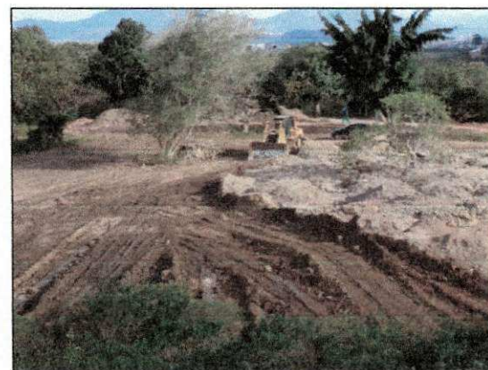
Espalhamento de material de bota-fora na área de bota-fora com auxílio de trator sobre esteiras (D6) da Construtora Rocha Cavalcante. (imagem de 08/11)
