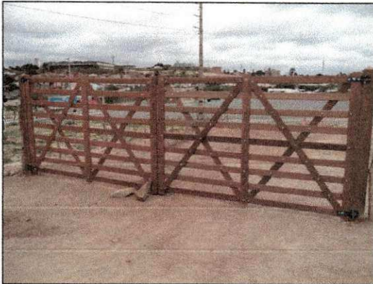
Portão de acesso instalado na entrada da obra. (imagem de 06/01/14)
