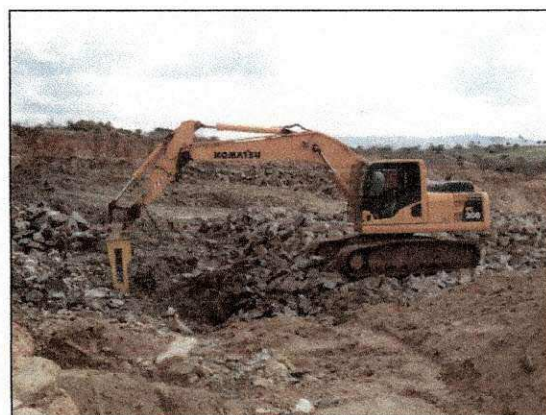
Desmonte de rocha de 1ª categoria com auxílio do rompedor hidráulico da RealMaq. (imagem de 24/12)
