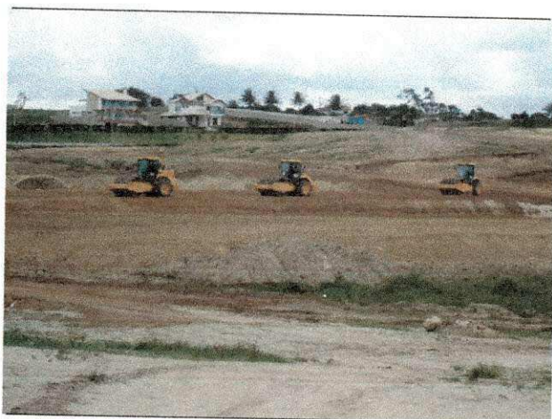
Continuação do lançamento e compactação de material nos Platôs 1 e 2.
