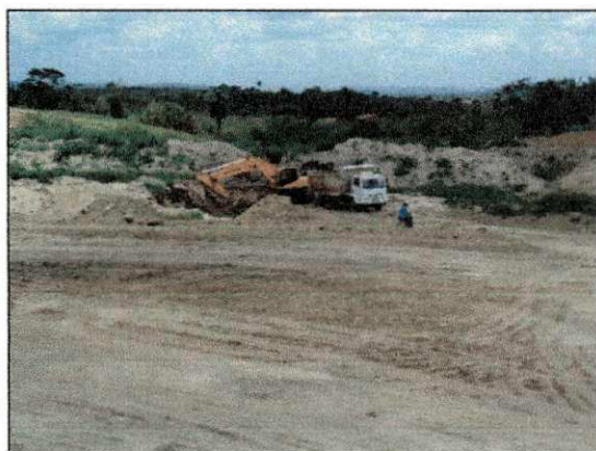
Retirada de material argiloso do fundo da antiga lagoa. (imagem de 18/10)
