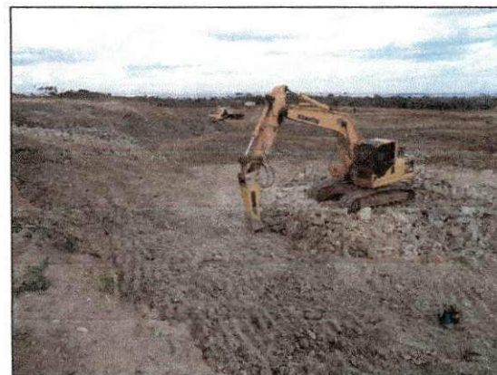
Desmorte de rocha com auxílio do rompedor hidráulico da RaiMaq. (imagem de 29/01/14)
