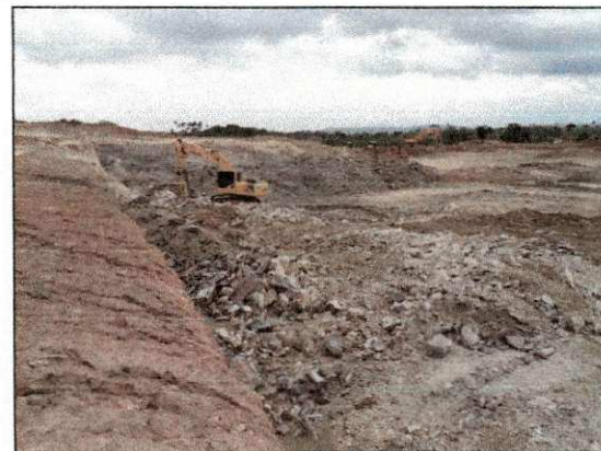
Continuação do desmonte de rocha branda pro'ximo à cortina com auxílio do rompedor hidráulico da RealMaq. (imagem de 19/02/14)
