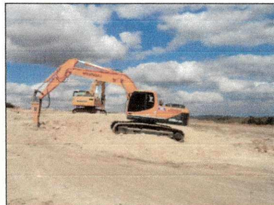
Desmonte de rocha branda com rompedor hidráulico da DETROL. (imagem de 29/10)
