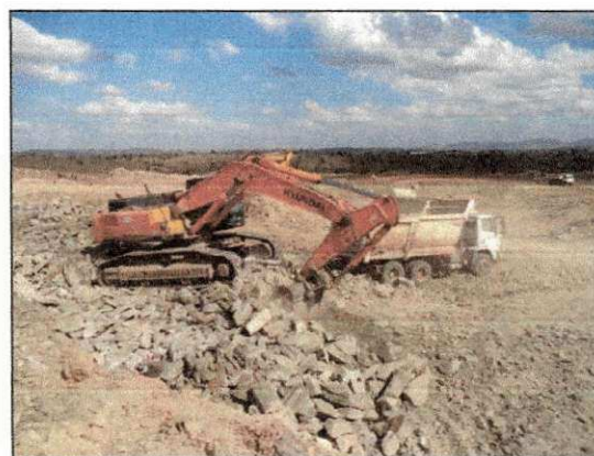
Retirada de material proveniente do desmonte de rocha dos rompedores hidráulicos. (imagem de 13/12)
