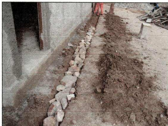
Início da execução das calçadas de contorno do bloco dos vestiários. (imagem de 24/12)
