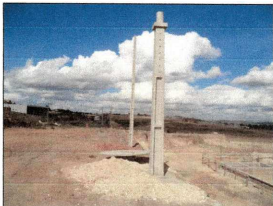
Instalação de postes destinados à instalação do quadro de energia elétrica e da caixa d'água que alimentarão os blocos operacionais. (imagem de 08/11)
