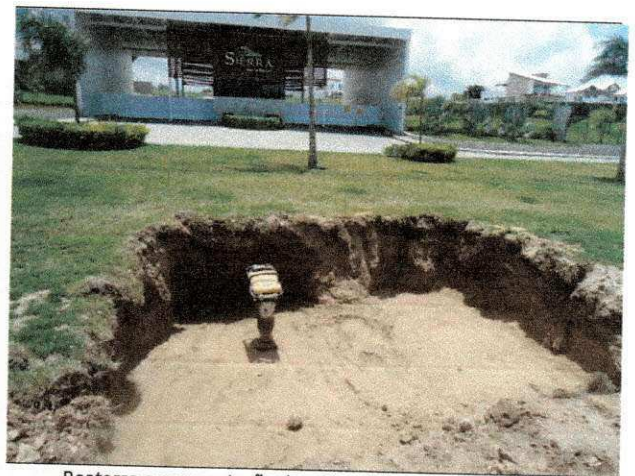
Reaterro e compactação de vala em frente ao terreno do shopping.
