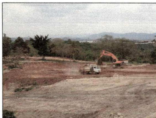
Carga de material argiloso da área de bota-fora para abafamento da 5ª detonação. (imagem de 21/02/14)
