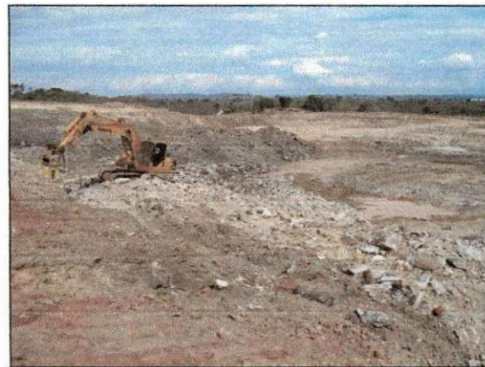
Desmonte de rocha branda com auxílio do rompedor hidráulico da RealMaq. (imagem de 07/02/14)
