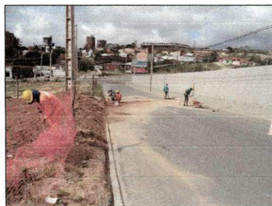
Ligação do esgoto dos blocos operacionais à rede pública. (imagem de 24/12)
