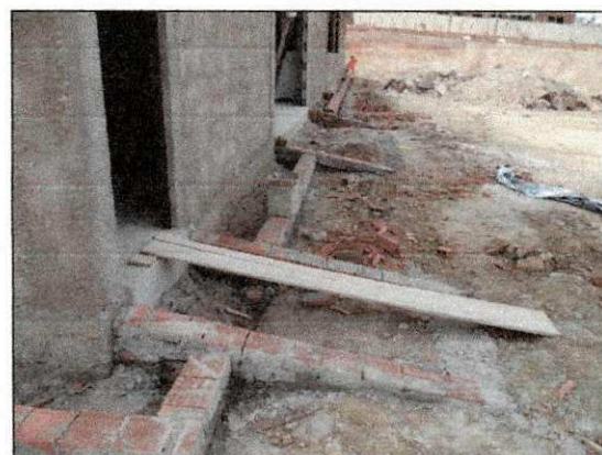
Execução da calçada de contorno do bloco do almoxarifado. (imagem de 17/01/14)
