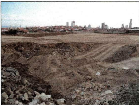
Início da retirada do material proveniente da 1ª detonação. (imagem de 10/01/14)
