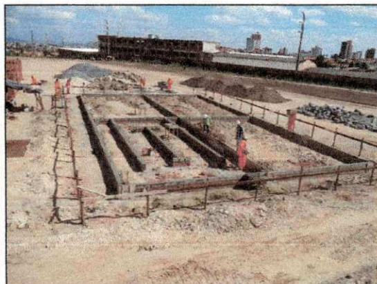
Execução da alvenaria de 1 vez e do cintamento inferior, inclusive concretagem de um dos blocos operacionais. (imagem de 29/10)
