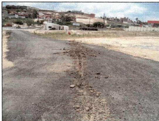
Retirada da instalação provisória de energia do bloco administrativo. (em 14/12)
