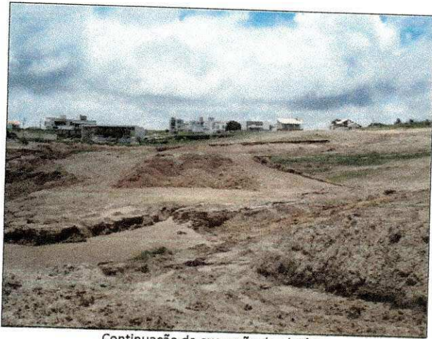
Continuação da execução do platô 3.
