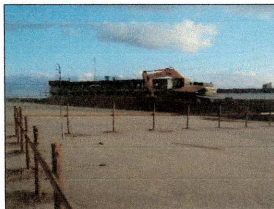
Execução do taludamento na parte lateral direita dos blocos operacionais. (imagem de 16/10)
