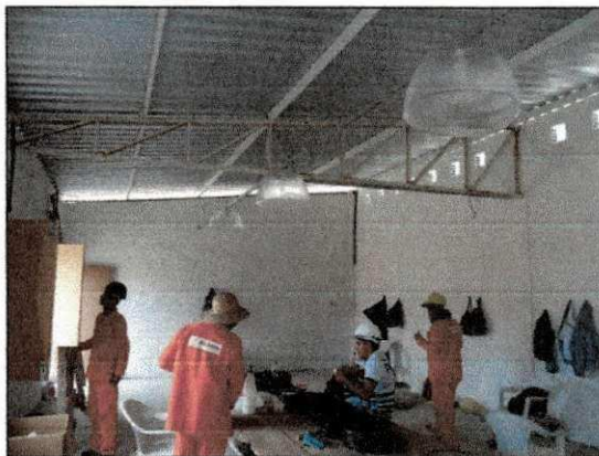
Finalização da instalação elétrica do bloco dos vestiários. (imagem de 17/01/14)
