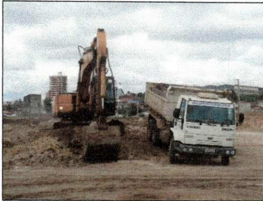
Retirada de material proveniente de desmonte de rocha branda feito com auxílio de rompedor hidráulico. (01/10)
