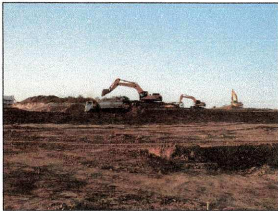
Corte e transporte de material na parte mais alta do terreno, próximo à cortina. (imagem de 21/10)
