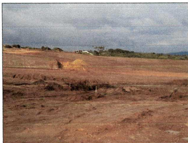
Vista do corte e compactação de material escavado no lado esquerdo do talvegue.
