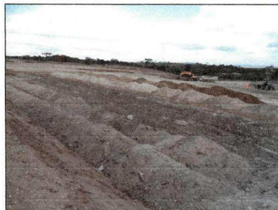
Continuação do lançamento de material sobre a antiga lagoa e a parte 2 do dreno. (imagem de 08/11)
