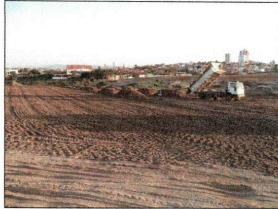
Lançamento de material nos platôs 9 e 10. (imagem de 21/10)
