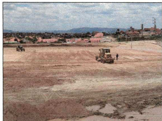
Acabamento do platô inferior do shopping com auxílio de motoniveladora. (imagem de 26/02/14)
