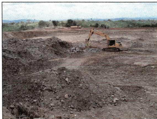
Desmonte de rocha decomposta com auxílio do rompedor hidráulico da RealMaq. (imagem de 26/02/14)
