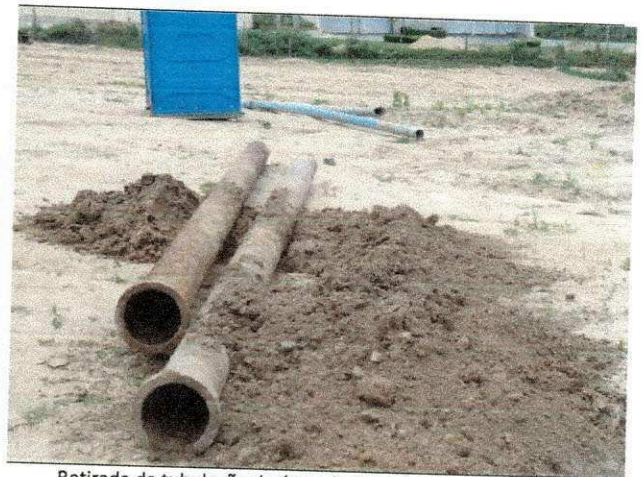
Retirada da tubulação de água da CAGEPA (ferro fundido).
