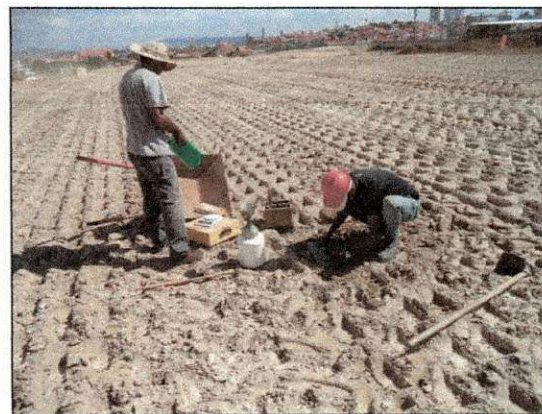
Ensaio de densidade in situ na parte 1 do dreno. (imagem de 05/12)
