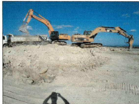
Desmonte e transporte de rocha branda na parte mais alta do terreno do shopping. (imagem de 02/10)
