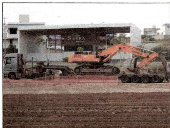
Substituição de máquina da Compecc. (imagem de 17/12)
