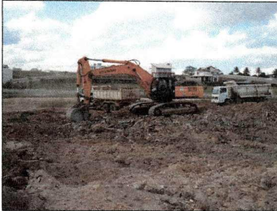
Transporte de material proveniente do desmonte de rocha decomposta feito pelos rompedores hidráulicos na área de escavação 03. (imagem de 20/11)
