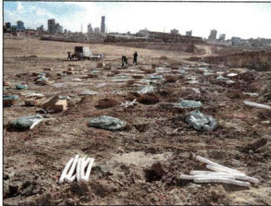
Operação de carregamento dos explosivos para a segunda detonação na área de escavação 01. (imagem de 29/11)
