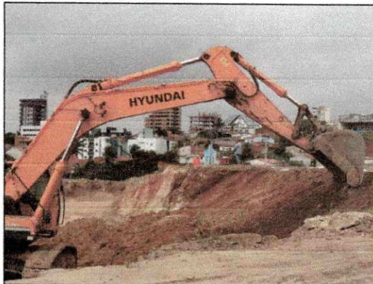
Execução de taludamento na parte frontal do terreno dos blocos operacionais. (09/10)
