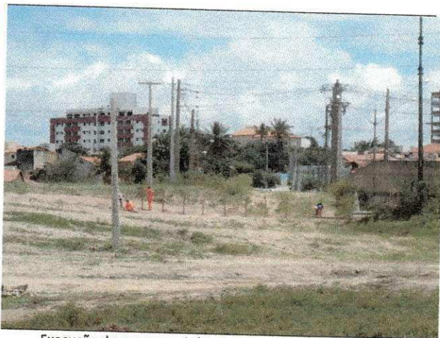
Execução de cerca provisória lateral oeste sul (ao lado da subestação da CHESF).
