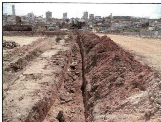
Escavação de vala para instalação de água para abastecimento dos blocos operacionais. (imagem de 13/12)
