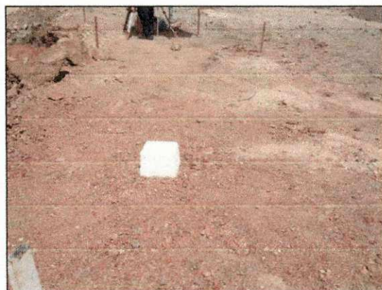
Instalação de marco topográfico. (imagem de 29/11)
