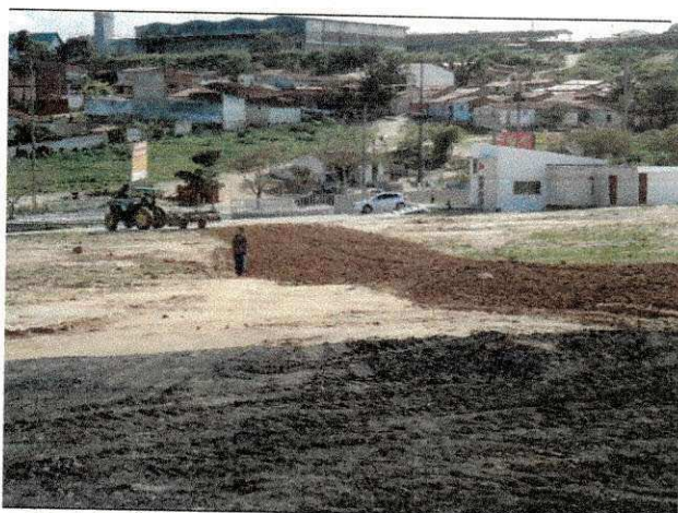
Regularização, lançamento, espalhamento de material utilizando motoniveladora e trator de grade, para receber camada de fresado no acesso ao bloco administrativo.
