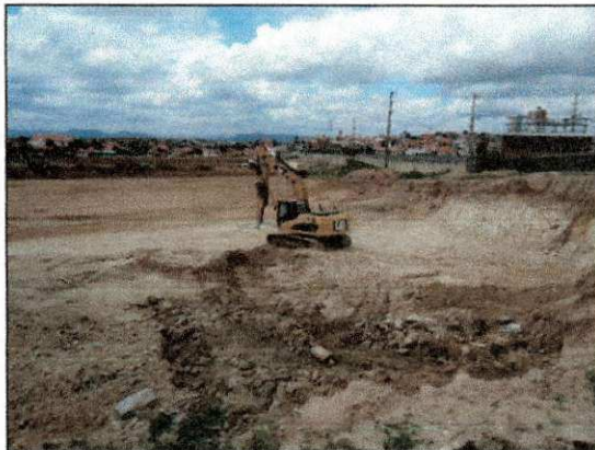
Desmonte de rocha branda com auxílio de rompedor hidráulico da Construtora Rocha. (01 à 04/10)
