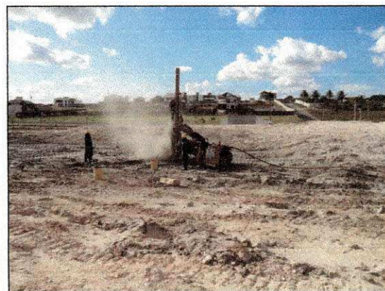
Trabalhos de perfuração em rocha para instalação de explosivos para a 3ª detonação. (imagem de 02/12)
