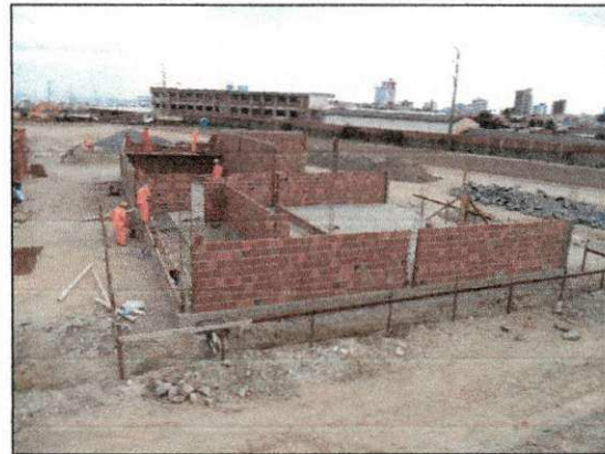
Execução da alvenaria de elevação com tijolos cerâmicos de 1/2 vez e execução das instalações de esgoto sanitário do bloco dos vestiários. (imagem de 14/11)
