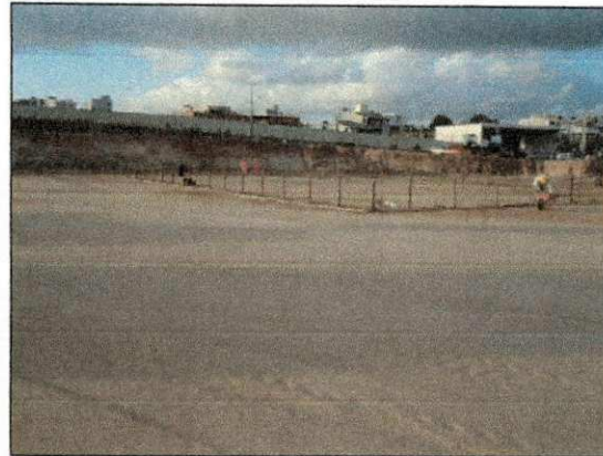
Execução de locação dos blocos operacionais com gabarito de madeira para início da construção. (imagem de 16/10)
