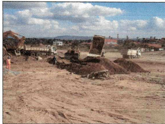
Lançamento de material de bota-fora para abafamento da segunda detonação na área de escavação 01. (imagem de 29/11)
