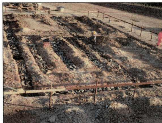
Execução do embasamento de pedra argamassada e concretagem dos fundos das valas das sapatas. (imagem de 21/10)
