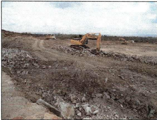
Retirada de material proveniente do desmonte de rocha feito com o auxílio do rompedor hidráulico da RealMaq. (imagem de 14/01/14)
