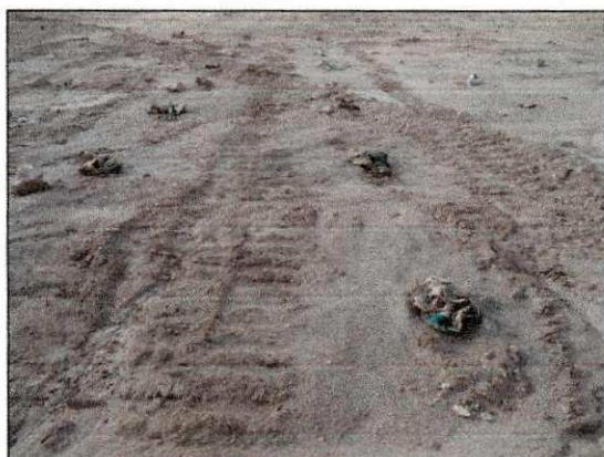
Furos para instalação dos explosivos para a primeira detonação na área de escavação 01. (imagem de 08/11)
