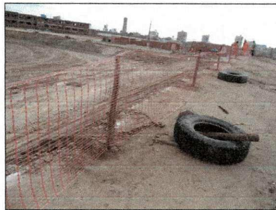
Instalação de telas guarda-corpo próximo aos taludes e cortinas. (imagem de 27/11)
