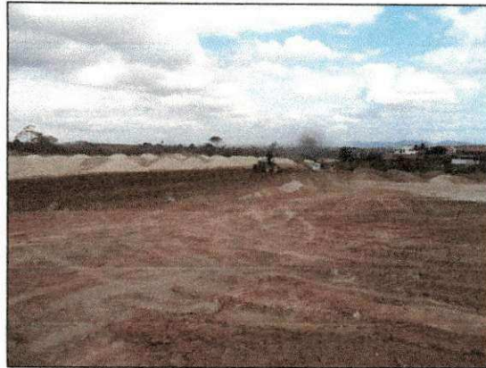
Espalhamento de material lançado nos platôs 09 e 10. (imagem de 20/11)
