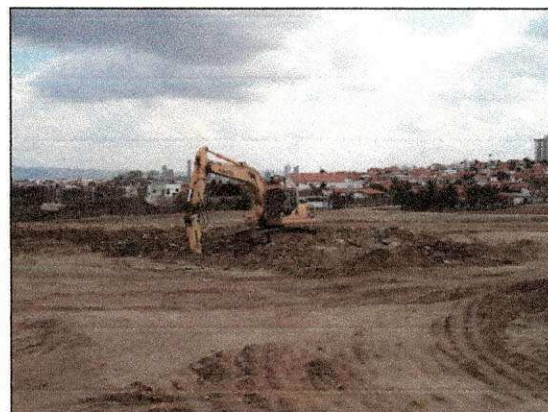
Desmonte de rocha com auxílio do rompedor hidráulico. (imagem de 14/01/14)
