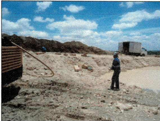
Carregamento de explosivos para a 6ª detonação. (imagem de 25/02/14)
