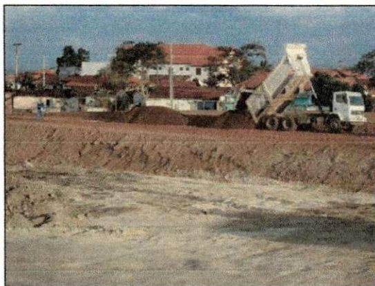
Lançamento de material nos platôs 4 e 5. (imagem de 16/10)
