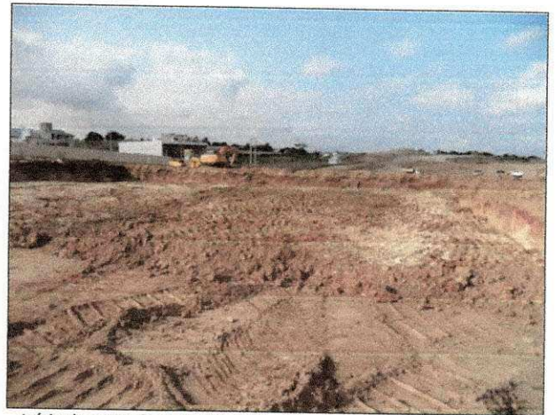
Início de corte de material de 1ª e 2ª categoria no extremo direito frontal do terreno do shopping.
