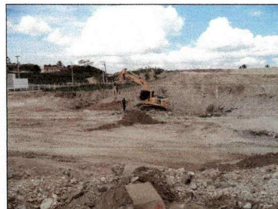
Desmonte de rocha na área da 3ª detonação com auxílio do rompedor hidráulico da RealMaq. (imagem de 20/02/14)
