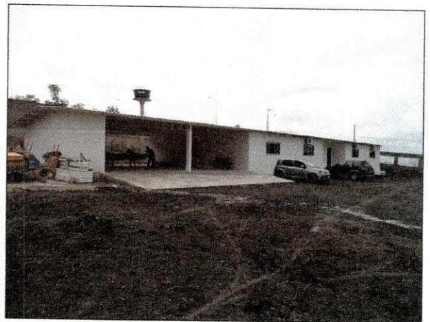
Construção do bloco administrativo (Concluído).
