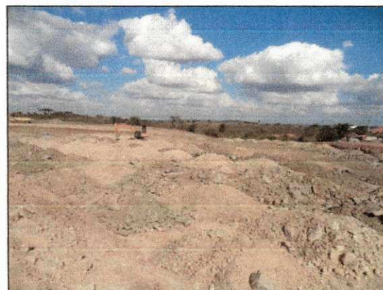
Material proveniente da primeira detonação na área de escavação 01, lançado sobre a antiga lagoa. (imagem de 27/11)
