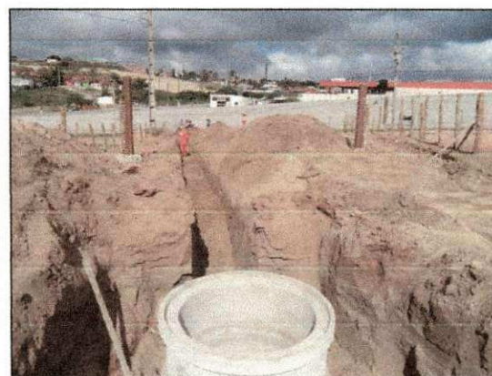
Pv construído e aterro de vala feita para instalação do tubo de esgoto ligado à rede pública. (imagem de 24/12)
