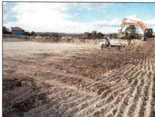
Extração de material em terreno vizinho ao shopping (lado extremo esquerdo) para utilização na terraplenagem. (imagem de 08/11)
