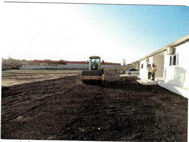
Acabamento com rolo liso de fresado em frente ao bloco administrativo.
