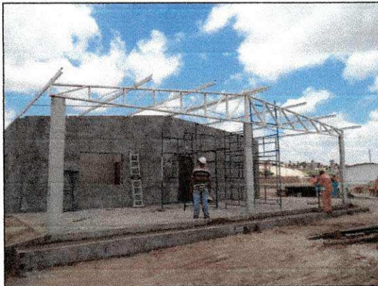
Execução da cobertura metálica do bloco administrativo 02. (imagem de 26/02/14)
