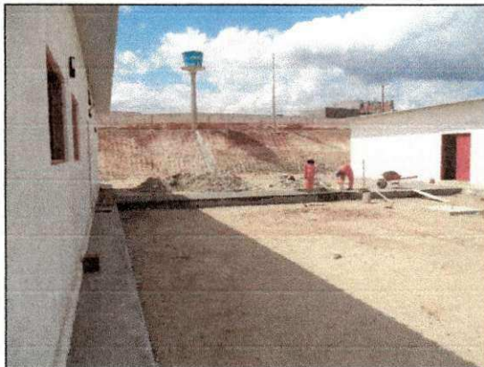
Execução de passarela interligando os blocos operacionais. (imagem de 13/02/14)
