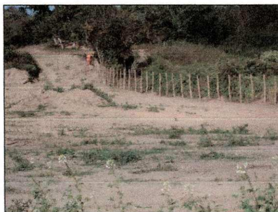
Continuação da instalação da cerca provisória nos fundos do terreno do shopping. (imagem de 08/11)
