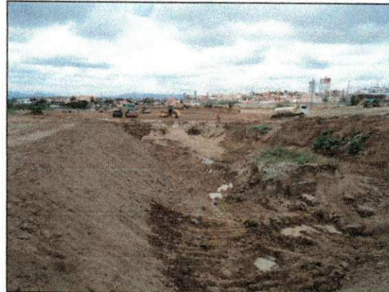
Continuação da retirada de material argiloso (bota-fora) do fundo do talvegue e continuação execução do dreno (partes 1 e 2). (Imagem de 01/10)
