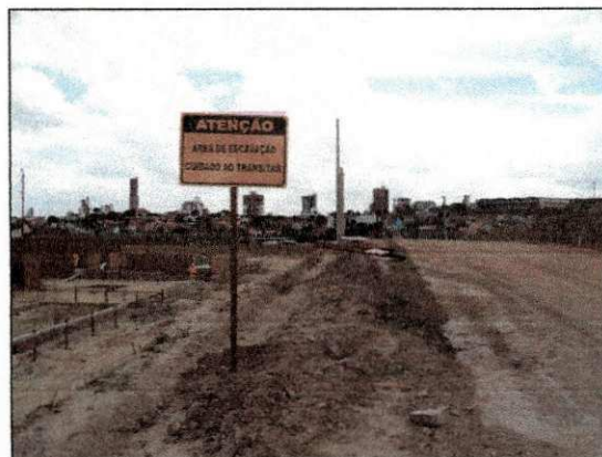
Instalação de placas de sinalização no entorno da obra. (imagem de 14/11)
