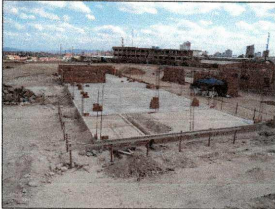
Conclusão parcial da laje de impermeabilização e início da execução da alvenaria de elevação no bloco do almorarifado. (imagem de 27/11)
