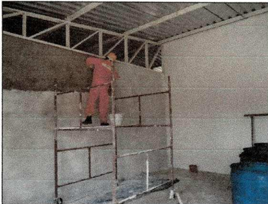
Pintura dos blocos operacionais. (imagem de 14/01/14)
