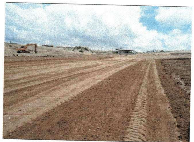
Continuação da execução do platô 3.
