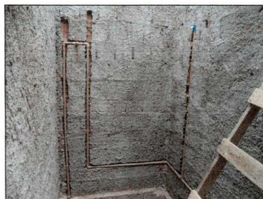
Instalação hidráulica do bloco administrativo 02. (imagem de 21/02/14)
