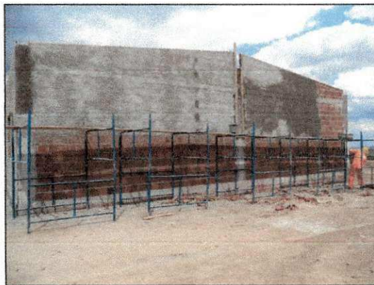
Execução do chapisco de aderência no bloco administrativo 02. (imagem de 07/02/14)
