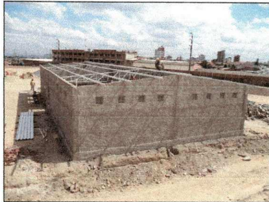
Instalação da cobertura metálica do bloco dos vestiários. (imagem de 05/12)
