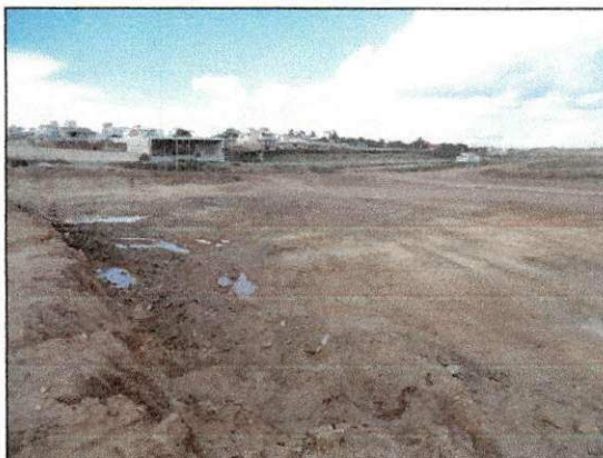
Conclusão da escavação do platô 06. (imagem de 08/11)
