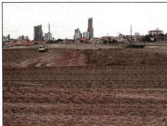
Lançamento de material sobre a antiga lagoa. (imagem de 14/01/14)
