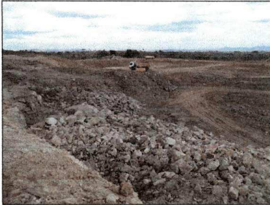
Área de desmonte de rocha feito pelo rompedor hidráulico; ao fundo retirada de material pedregulhoso. (imagem de 29/01/14)
