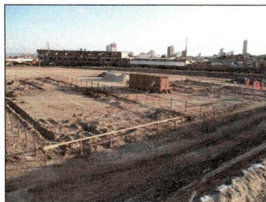
Escavação de valas dos blocos operacionais com o auxílio de retro-escavadeira no dia 19/10. (imagem de 21/10)
