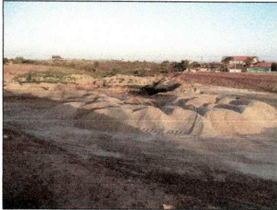
Estoque de areia para o dreno. (imagem de 21/10)
