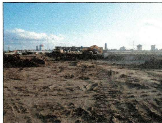
Escavação do platô 6, ao lado dos blocos operacionais. (imagem de 16/10)
