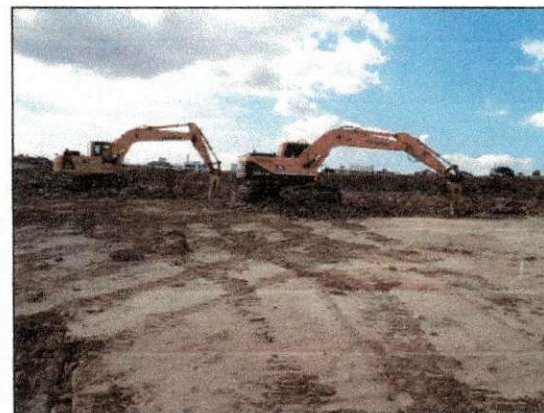
Desmorte de rocha decomposta com auxílio dos rompedores hidráulicos da Detrol e RealMaq entre as áreas de escavação 01 e 02. (imagem de 29/11)
