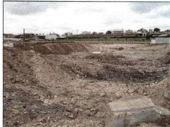
Área de retirada de material proveniente da 4ª detonação. (imagem de 19/02/14)
