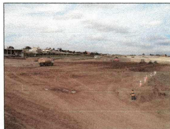
Espalhamento e compactação de material lançado na parte frontal da obra - platô 6, platô 7 e parte 1 do dreno. (imagem de 17/12)
