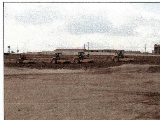
Compactação de material próximo ao platô frontal do shopping. (imagem de 14/01/14)
