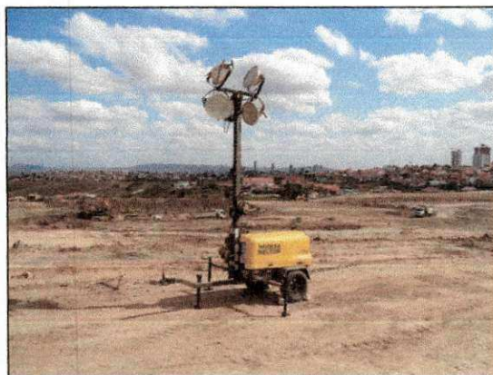
Torre de iluminação (xuxinha) instalada para auxiliar os trabalhos de instalação de explosivos para a segunda detonação na área de escavação 01. (imagem de 27/11)
