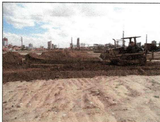
Raspagem do platô inferior do shopping - correção de nível. (imagem de 20/02/14)
