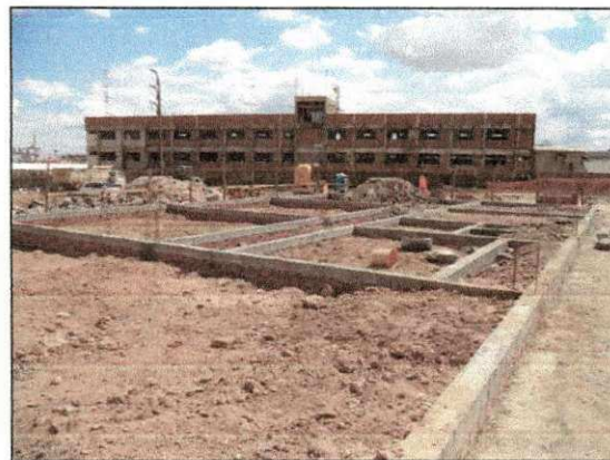
Aterro do caixão com solo de empréstimo no novo bloco administrativo. (imagem de 29/01/14)
