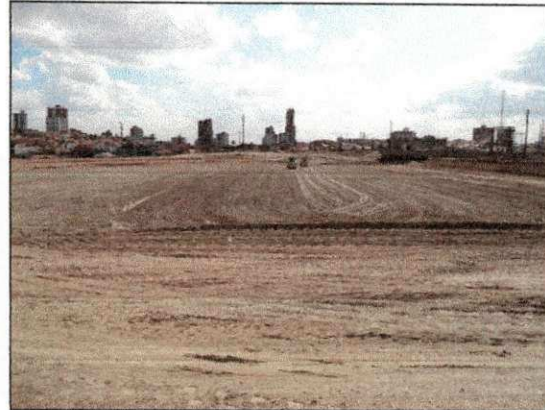
Compactação de material na área da antiga lagoa. (imagem de 13/12)
