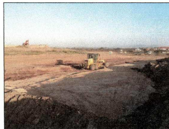
Espalhamento de material lançado proveniente de rocha decomposta na parte 1 do dreno. (imagem de 21/10)
