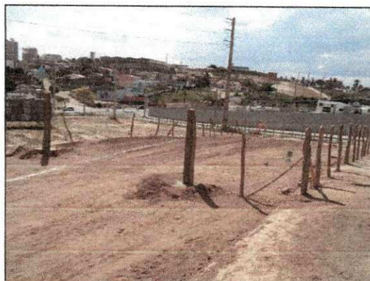
Início da execução do acesso principal da obra. (imagem de 13/12)
