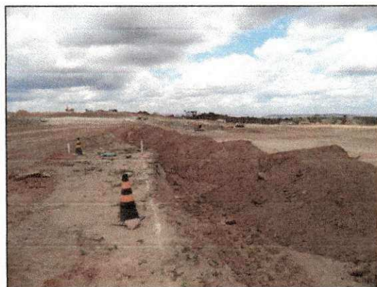
Lançamento de material próximo ao platô frontal do shopping. (imagem de 29/01/14)
