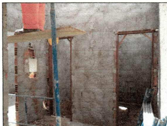
Início do assentamento das fôrmas do bloco administrativo 02. (imagem de 20/02/14)
