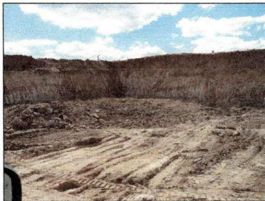
Vista frontal da cortina (ponta direita do prédio do shopping). (imagem de 29/10)
