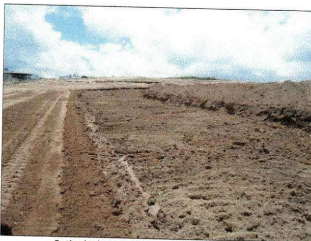
Retirada de material mole ao lado do platô 3.
