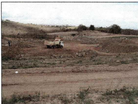
Lançamento de material no antigo açude, nos fundos do terreno do shopping. (imagem de 14/01/14)
