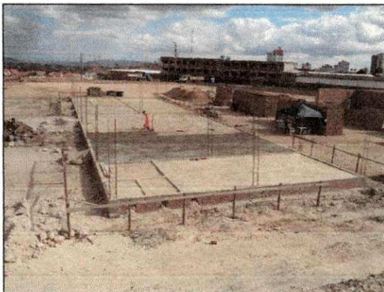
Concluído o aterro do caixão, execução da laje de impermeabilização do bloco do almoxarifado. (imagem de 20/11)
