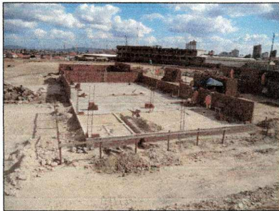
Continuação da execução da alvenaria de elevação do bloco do almoxarifado. (imagem de 29/10)
