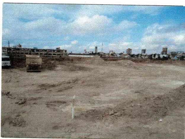
Continuação do corte na área onde serão instalados os blocos operacionais.
