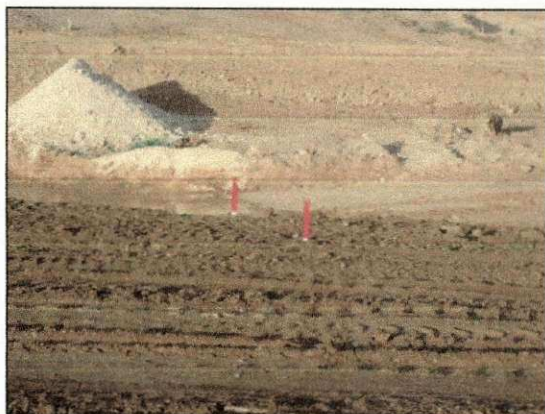
Colocação de piquetes, na cor vermelha, para localização do prédio do shopping. (imagem de 16/10)
