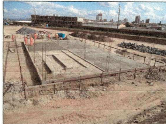
Conclusão do aterro do caixão e continuação da laje de impermeabilização do bloco dos vestiários. (Imagem de 08/11)
