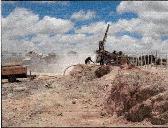
Perfuração em rocha para futura detonação com auxílio perfuratriz pneumática da DETEX. (imagem de 26/02/14)
