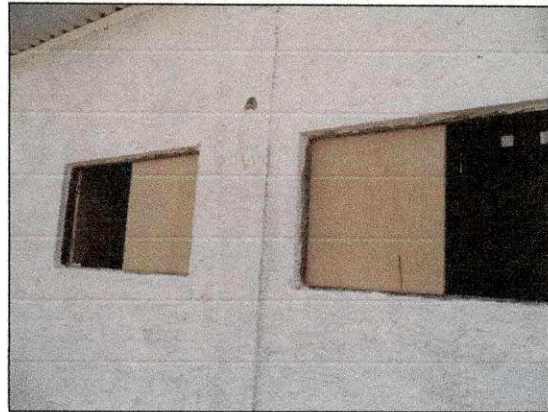
Assentamento de janelas feitas de portas de MDF serradas nos blocos operacionais. (imagem de 14/01/14)
