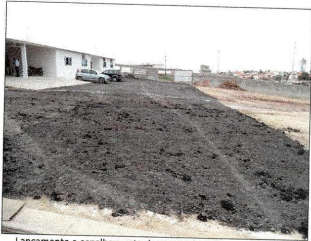
Lançamento e espalhamento de material asfáltico em frente ao bloco administrativo.
