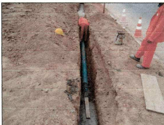
Envolvimento com concreto do tubo de abastecimento de água que passa em frente a entrada da obra. (imagem de 14/01/14)
