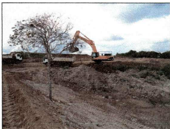
Carga de material argiloso da área de bota-fora para abafamento da 5ª detonação. (imagem de 20/02/14)
