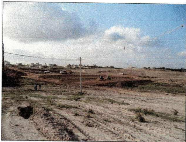
Vista geral parcial dos trabalhos no terreno do shopping.
