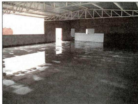
Cura do piso em cimento alisado do refeitório do bloco do almoxarifado. (imagem de 17/01/14)
