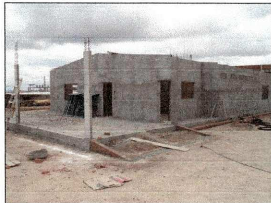
Conclusão das empenas e do chapisco de aderência do bloco administrativo 02. (imagem de 19/02/14)
