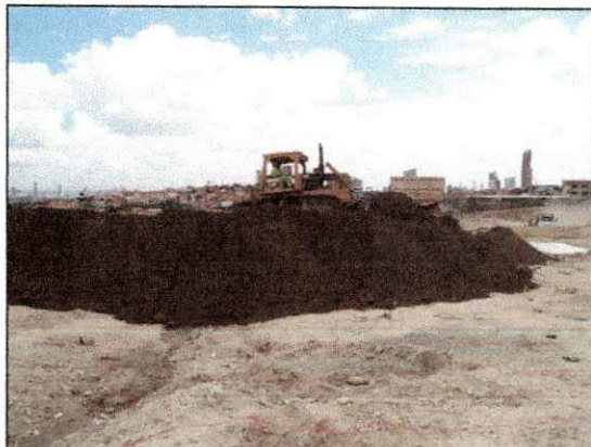
Lançamento de material argiloso estocado para abafamento da 5ª detonação. (imagem de 20/02/14)
