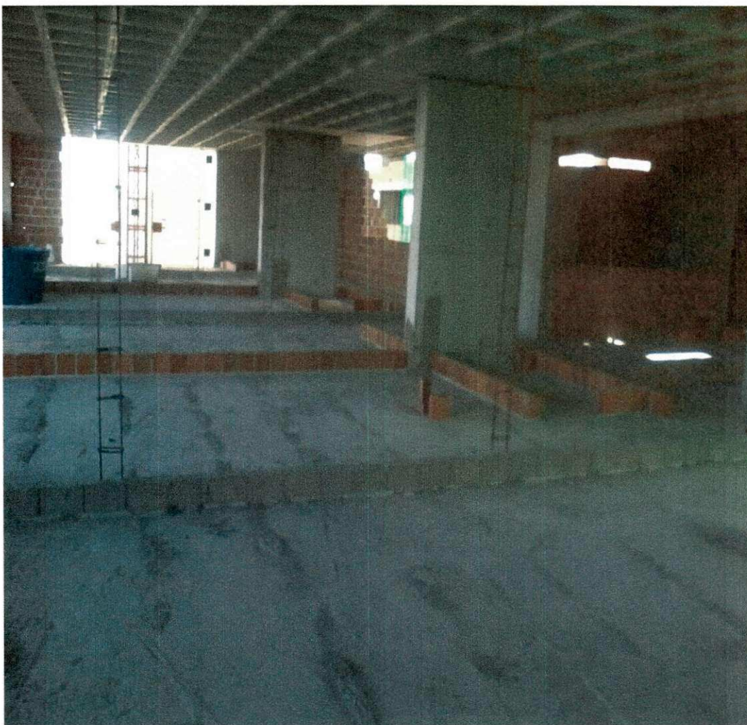
Figura 14: Marcação de alvenaria interna no Mundo Plaza (Bloco A)
