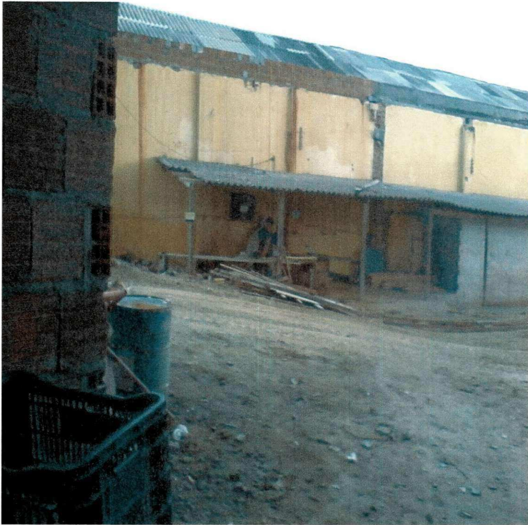
Figura 23: Área destinada aos serviços de carpintaria da obra.
