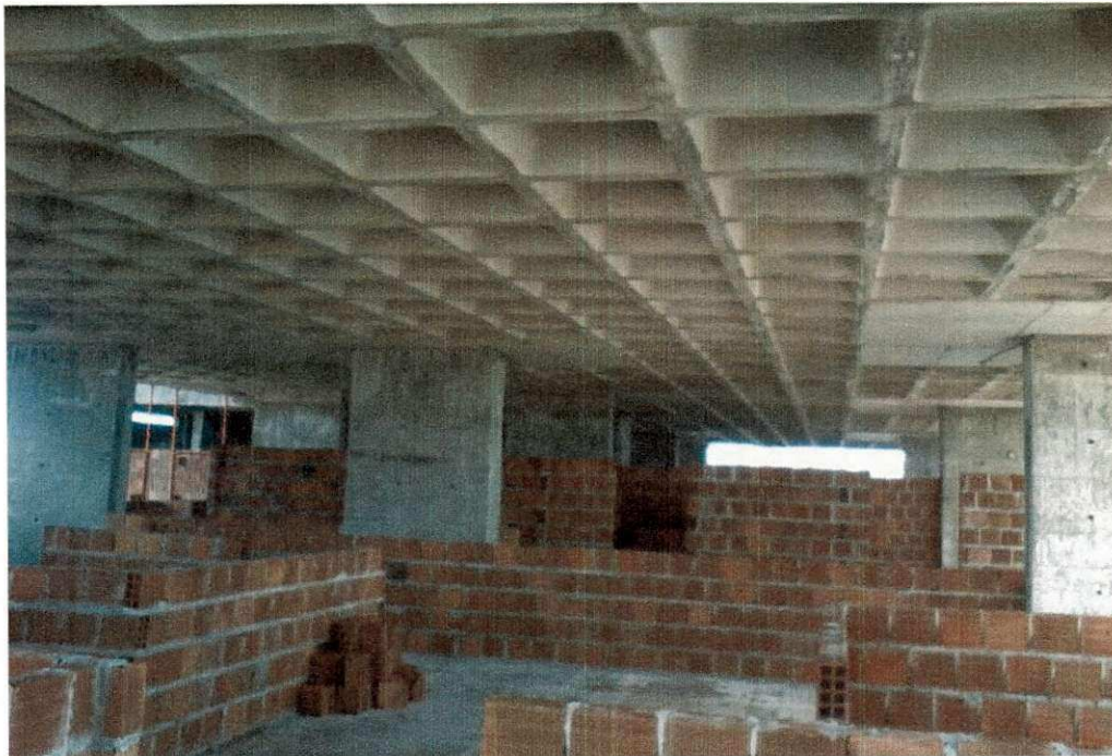
Figura 20: Serviços de alvenaria no Mundo Plaza (Bloco B)
