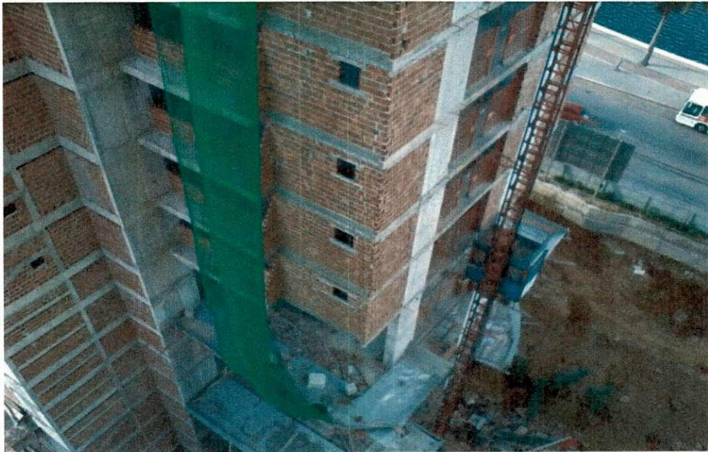
Figura 15: Fachada do Mundo Plaza (Bloco A)
