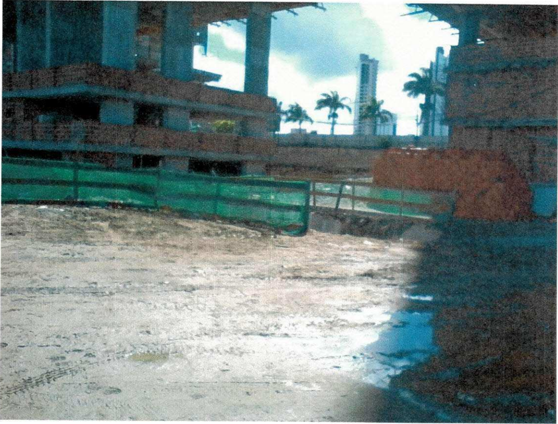
Figura 21: Colocação de guarda - corpos em rampas e locais de risco.
