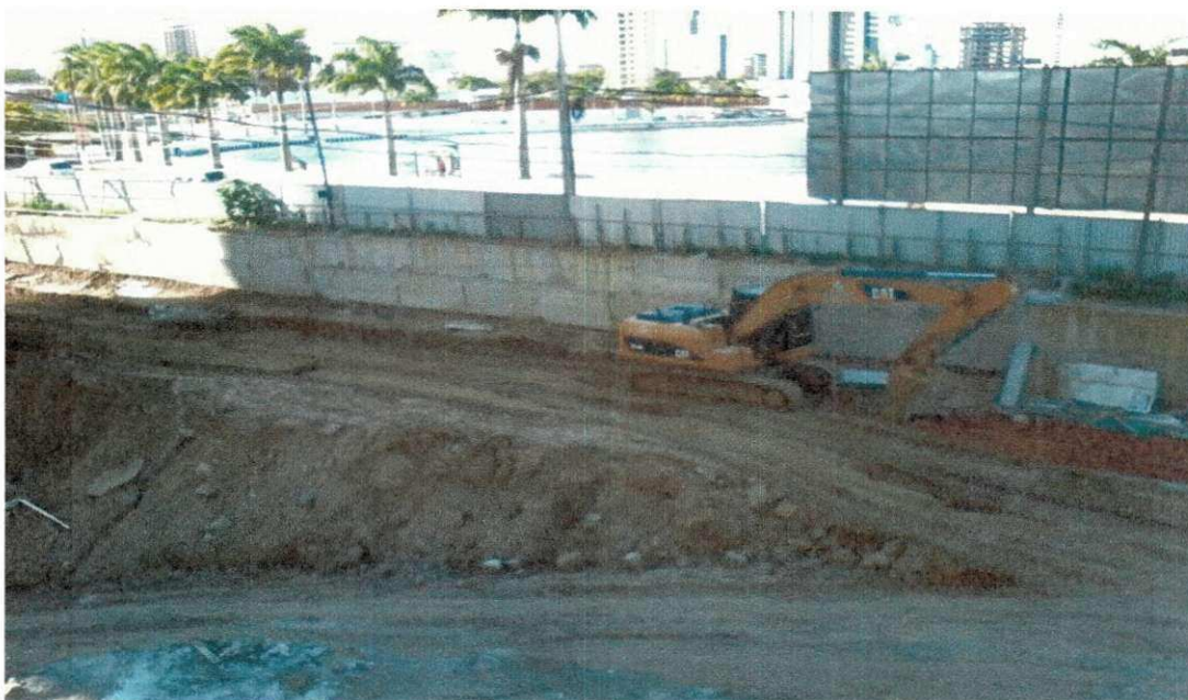
Figura 12: Parte do Muro de contenção ainda em execução, Mundo Plaza.
