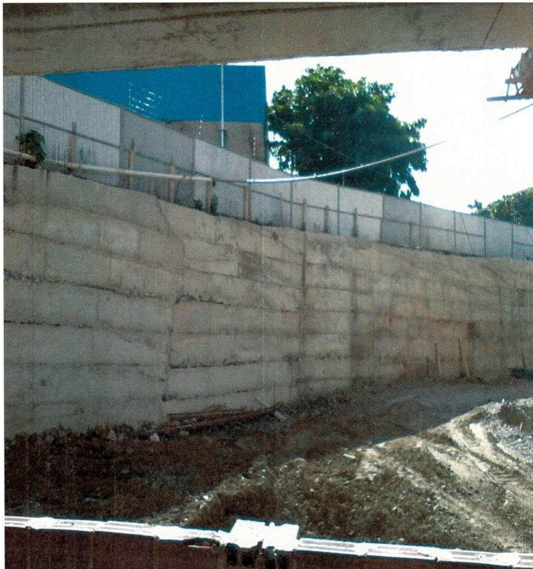
Figura 11: Muro de arrimo já concluído, Mundo Plaza.
