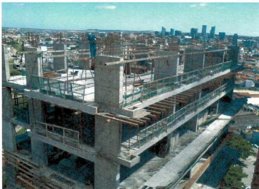
Figura 13: Montagem da laje do pavimento - tipo 15, Mundo Plaza (Bloco B).
