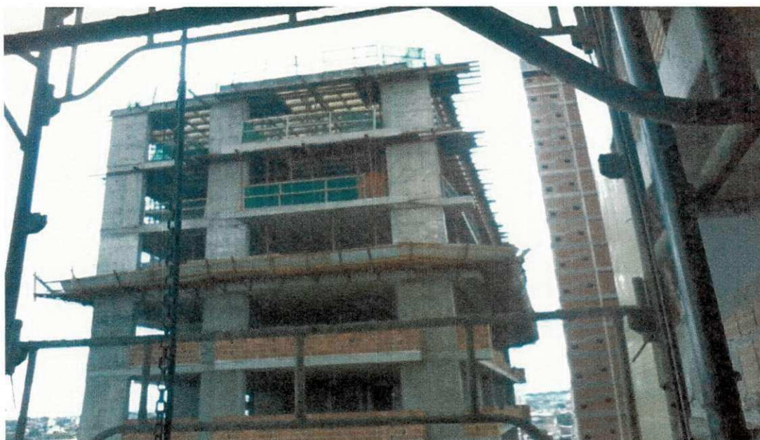
Figura 26: Fôrmas e escoramento na Laje Tipo 16 do Mundo Plaza (Bloco B).
